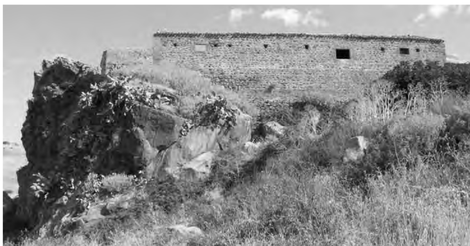
Fig. 2 – Costruzione realizzata sulla rocca nel casale di Arcodaci
