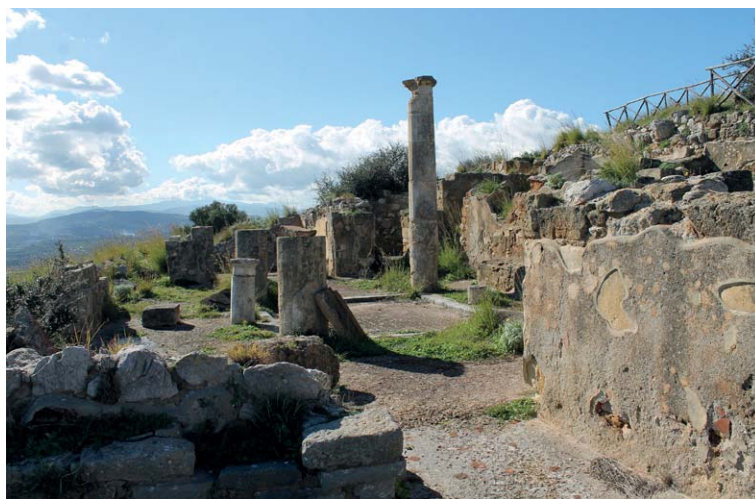
Fig. 1. Solunto (Palermo). Foto dell’area archeologica in cui si può notare lo stato di conservazione dei resti (foto C. La Mantia 2023).
