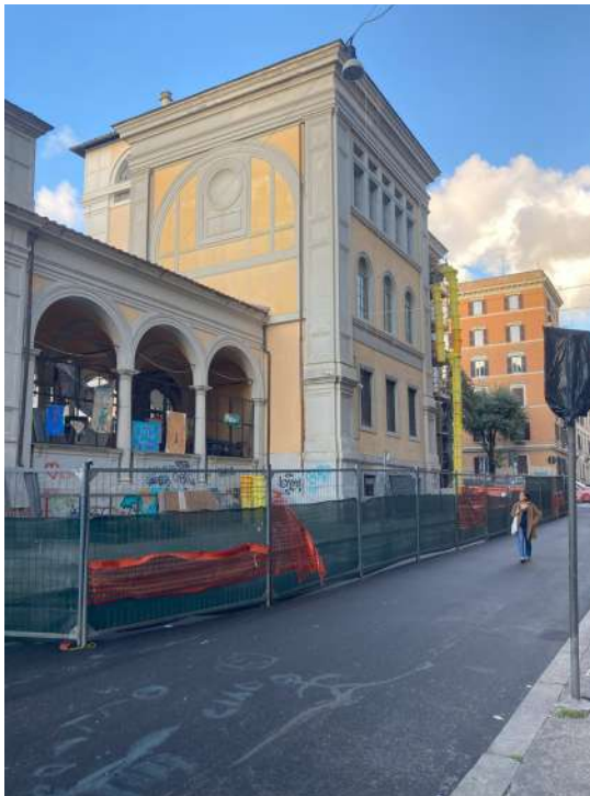
Fig. 4 Via Nino Bixio e il cantiere dei lavori per l'adeguamento sismico del plesso scolastico.
