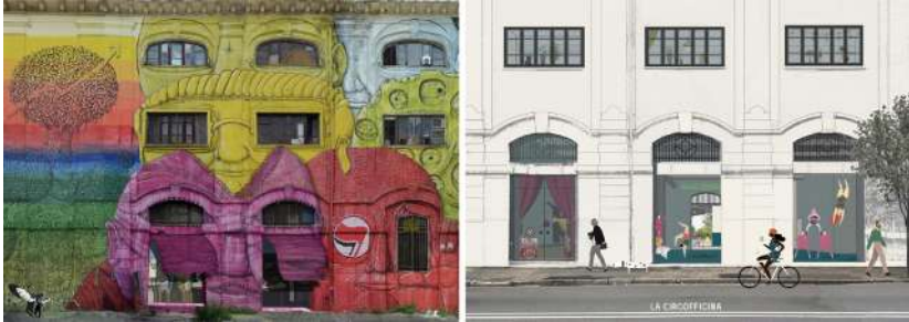
Fig. 4 Immagini della facciata prima e dopo il progetto Porto Fluviale RecHouse. Immagini di Laboratorio CIRCO dalla relazione di progetto).
