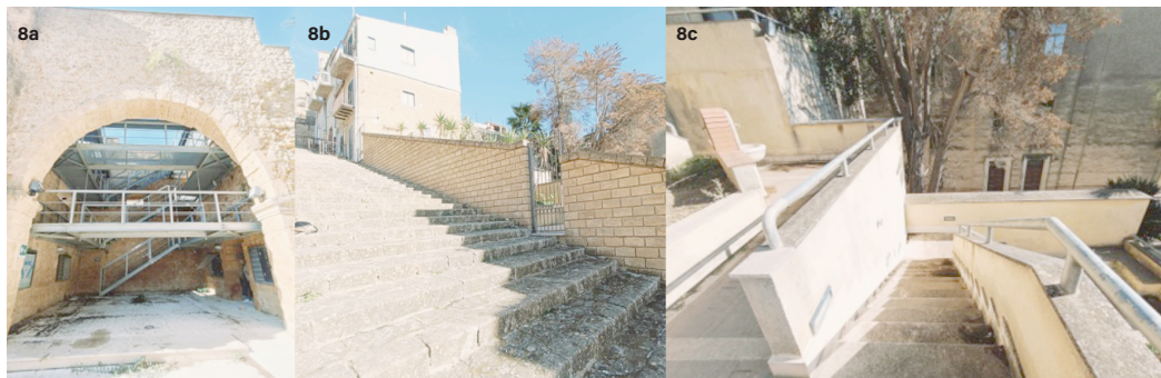
Figura 8. 8a: La escalera de acero construida dentro del Quarto Nobile. 8b: Dos pequeñas puertas metálicas, situadas a lo largo de la escalera, delimitan el difícil acceso al jardín colgante. 8c: Un estrecho tramo de escaleras que conecta los tres niveles pone de relieve la inaccesibilidad para personas con movilidad reducida.
