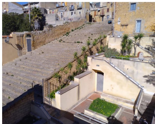
Figura 5. Tramo de la escalera de via Duomo y el espacio que fue objeto de una intervención de recuperación por parte del Municipio de Naro.
