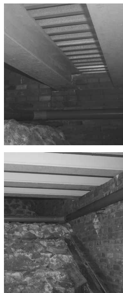
Fig. 7 Intradosso del solaio galleggiante del 1997 (L. Ferlito).
