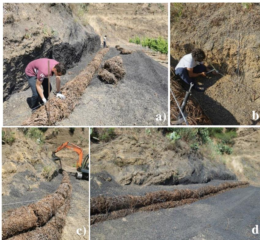
Figura 3.72 Messa in opera Prototipo A2; a) allineamento e collegamento fascinata, b) tensionamento cavi, c) riempimento a tergo, d) opera ultimata.
