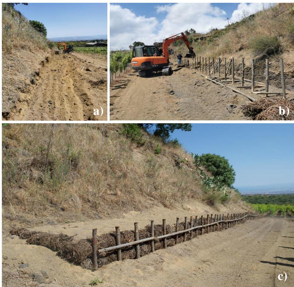
Figura 3.71 Messa in opera prototipo A1; a) scavo, b) realizzazione palizzata, c) opera finita.
