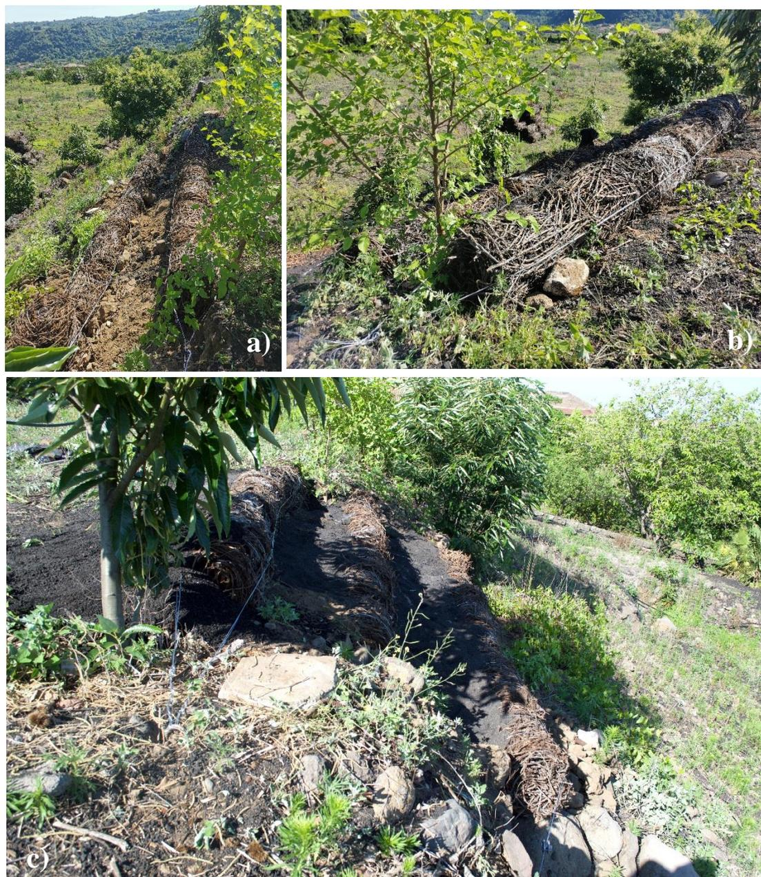
Figura 3.74 Messa in opera prototipo B2; a) posa dei primi due gradini, b) dettaglio dei cavi di collegamento e dell'ancoraggio, c) opera finita
