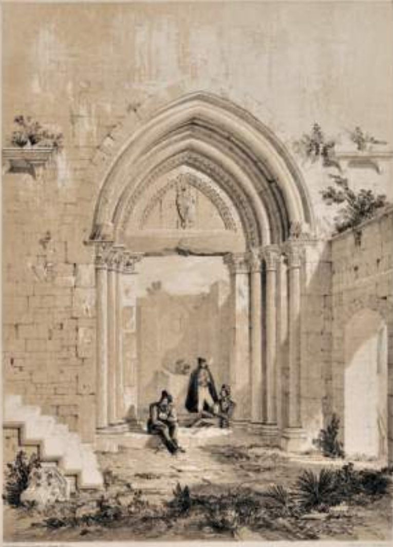
ARCADE DE L'ÉGLISE DE SAINT-PIERRE
