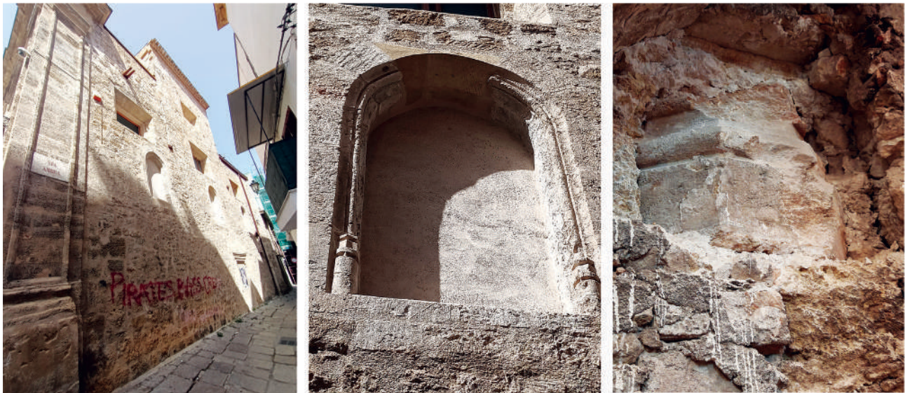
Fig. 4: Palermo. Chiesa di Sant'Andrea Apostolo: veduta del fronte su via Ambra (foto a sinistra); monofora (al centro); una delle basi ottagonali in pietra utilizzata come materiale di riempimento per chiudere l'arco (dell'autrice)
