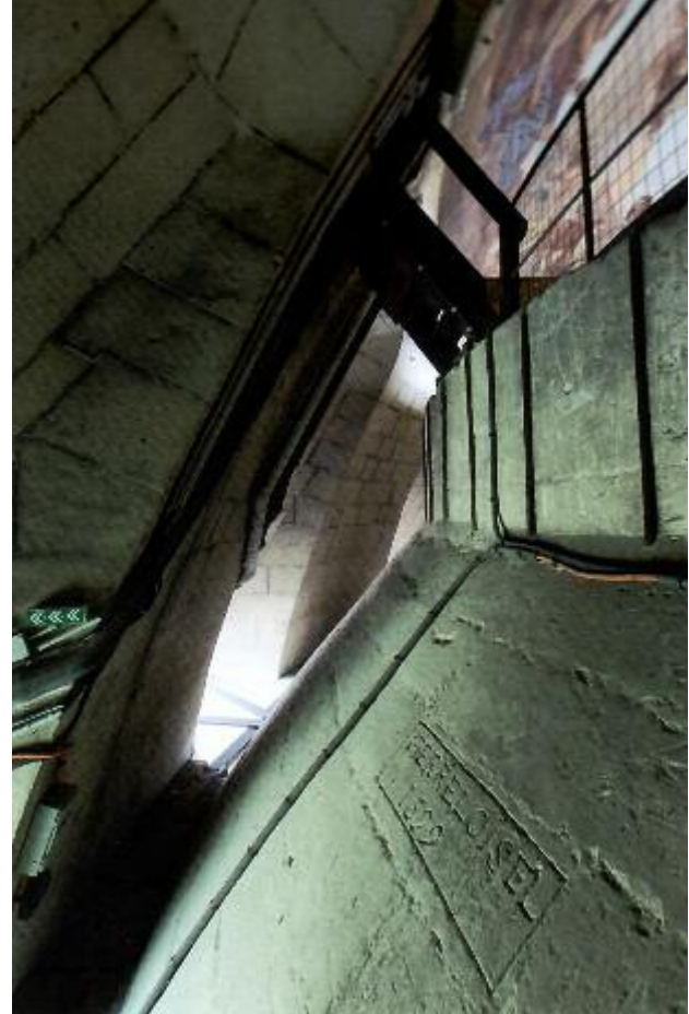
Fig. 48. Parigi. Vista dello spazio compreso fra la cupola tronca e la seconda calotta nella copertura dell'église royale dell'hôtel des Invalides (da GADY 2016, p. 78).
