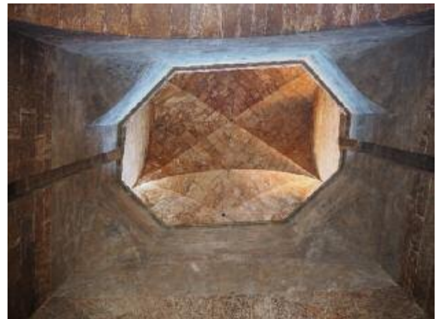
Fig. 2. Valencia. Torri di Quart, vista delle volte a crociera della tribuna centrale (foto A. Antista).
