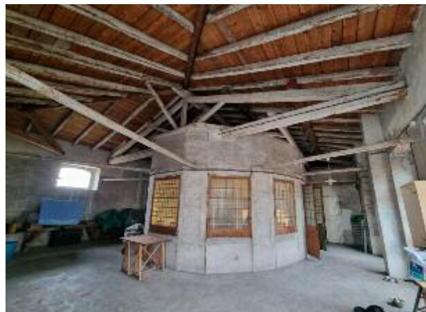
Fig. 6. Catania. Palazzo Biscari, veduta esterna della lanterna e del sistema di ancoraggio lineo alle falde del tetto (foto di D. Sutura).
