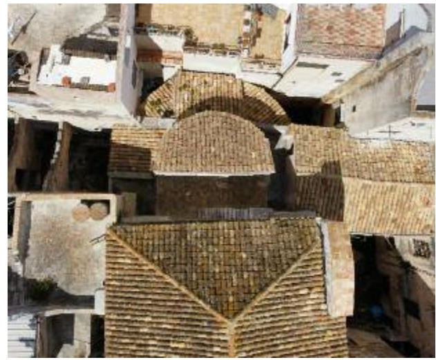
Fig. 6. Ripresa da drone del sistema di coperture della chiesa dell'Immacolatella a Trapani (foto M. Cannella).
