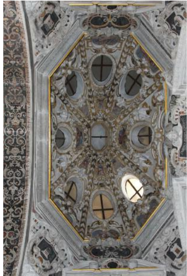
Fig. 14. Palermo. Chiesa dell'Immacolata Concezione, veduta della copertura absidale (foto di D. Sutura).
