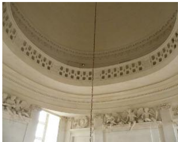
Fig. 14. Maison-Lafitte. Copertura della scala dello château, opera di François Mansart, 1642-43 https://creativecommons.org/licenses/by-sa/4.0/deed.en
