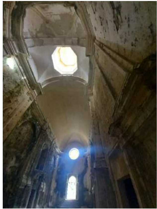
Fig. 46. Marsala. Chiesa di Santa Maria della Grotta, veduta interna e delle fonti di illuminazione (foto di M. Cannella).
