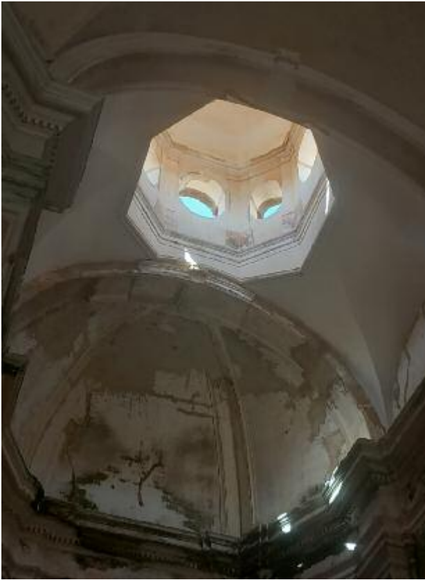
Fig. 45. Marsala. Chiesa di Santa Maria della Grotta, veduta interna del congegno absidale (foto di M. Cannella).
