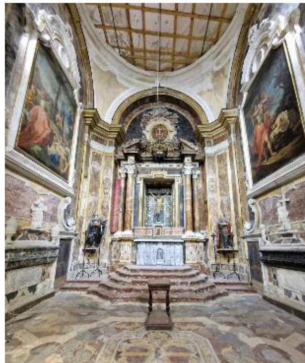
Fig. 65. Trapani. Chiesa di San Domenico, cappella del SS.mo Crocifisso prima del restauro con la copertura nascosta da una struttura in legno e telone in plastica (foto di E. Vetere).
