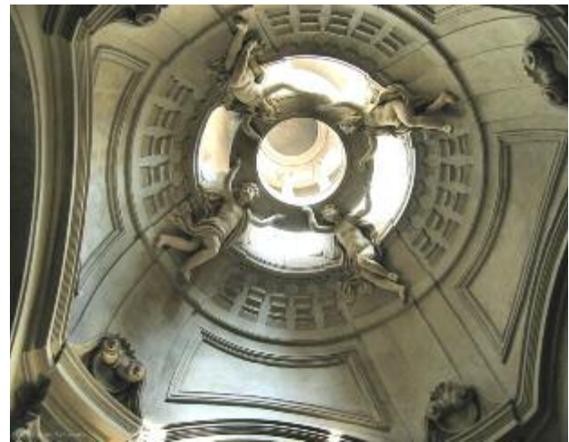
Fig. 57. Roma. Copertura principale della cappella Avila in Santa Maria in Trastevere.
