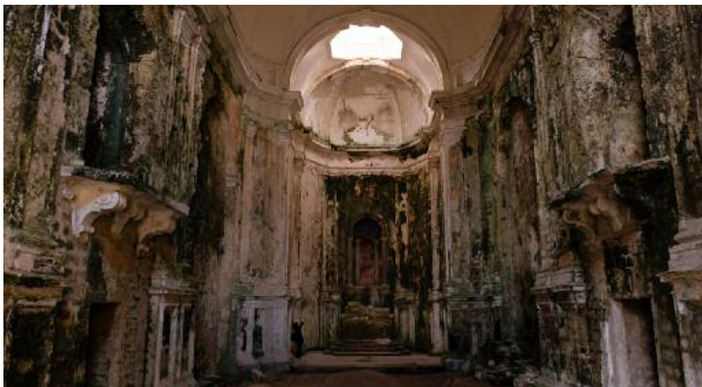
Fig. 30-31. Marsala. Complesso di Santa Maria della Grotta, veduta aerea e interno (foto di M. Cannella).
