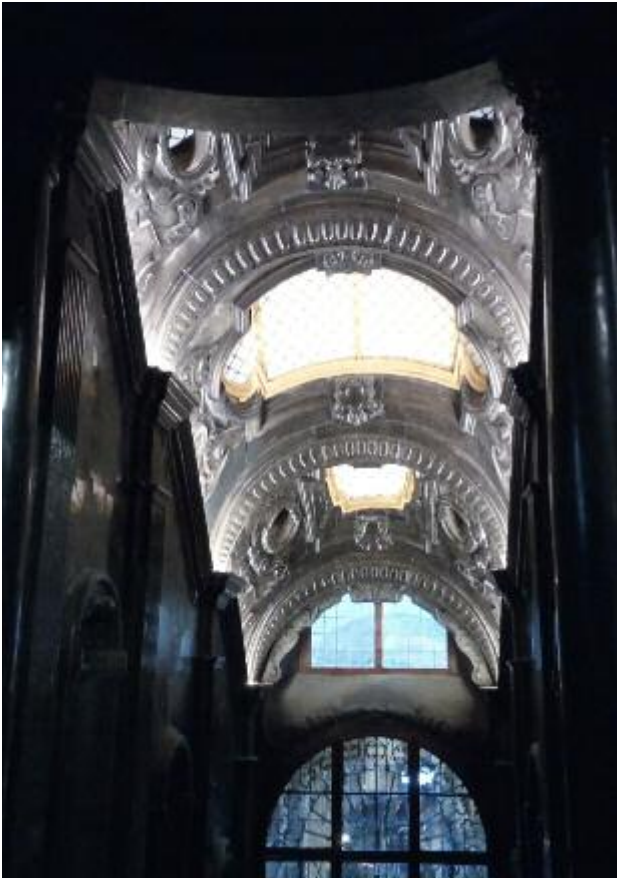
Fig. 41. Torino. Copertura di una delle scale di accesso alla cappella del SS: Sudario dal Duomo di San Giovanni Battista (foto di G. Nuccio).
