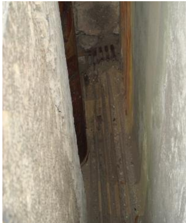
Fig. 67. Trapani. Chiesa di San Domenico, cappella del SS.mo Crocifisso, particolare dell'intercapedine lungo la cornice con i binari per lo scorrimento dei pannelli riproducenti i "misteri dolorosi" (foto di L. Biondo).
