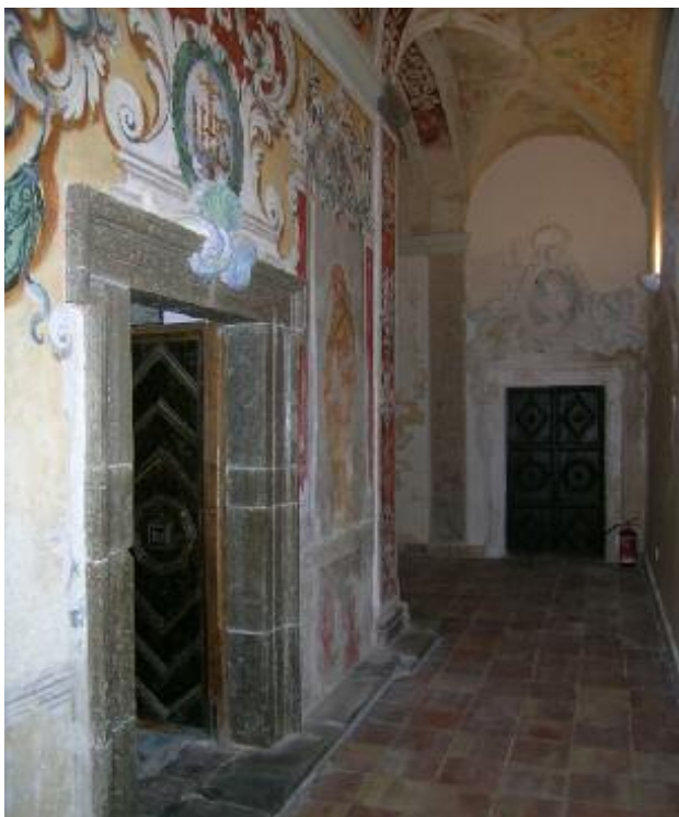
Fig. 25. Salemi, complesso dei Gesuiti, Santa Casa, veduta del corridoio perimetrale (foto di D. Sutura).
