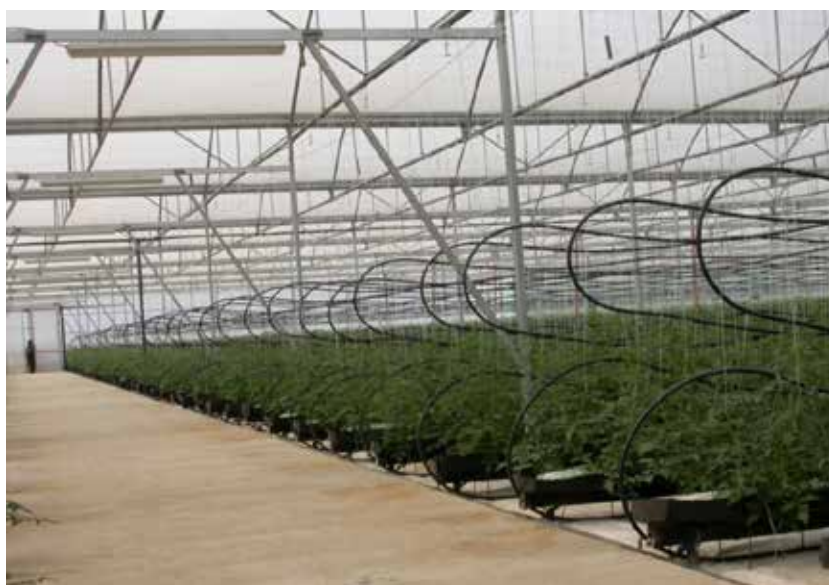
Colture di pomodoro dotate di impianti di riscaldamento localizzato.
