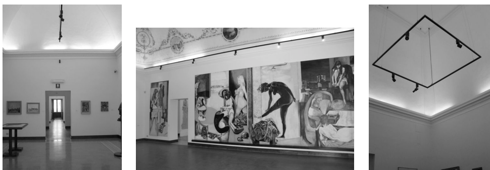
figg. 8-10. Villa Cattolica, corpo centrale, piano primo, sistema d'illuminazione con luce diffusa creata con corpi illuminanti, posti all'interno di una canaletta e luce diretta con binari e spot (foto R. Scaduto, 2014)
