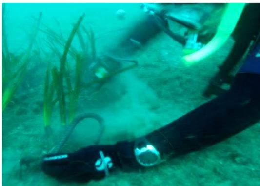
**Figura 3** – Ancoraggio di una griglia.
