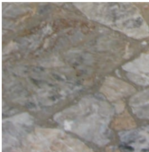
Figura 65: Scuola Elementare - La pavimentazione del piano terra della scuola elementare.
