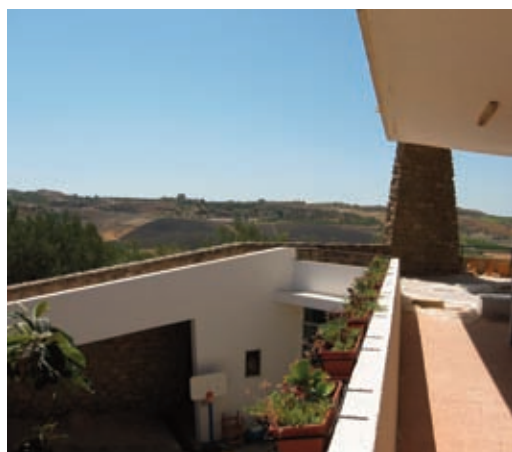
Figura 40: Asilo, particolare della rampa d'accesso al terrazzo.
