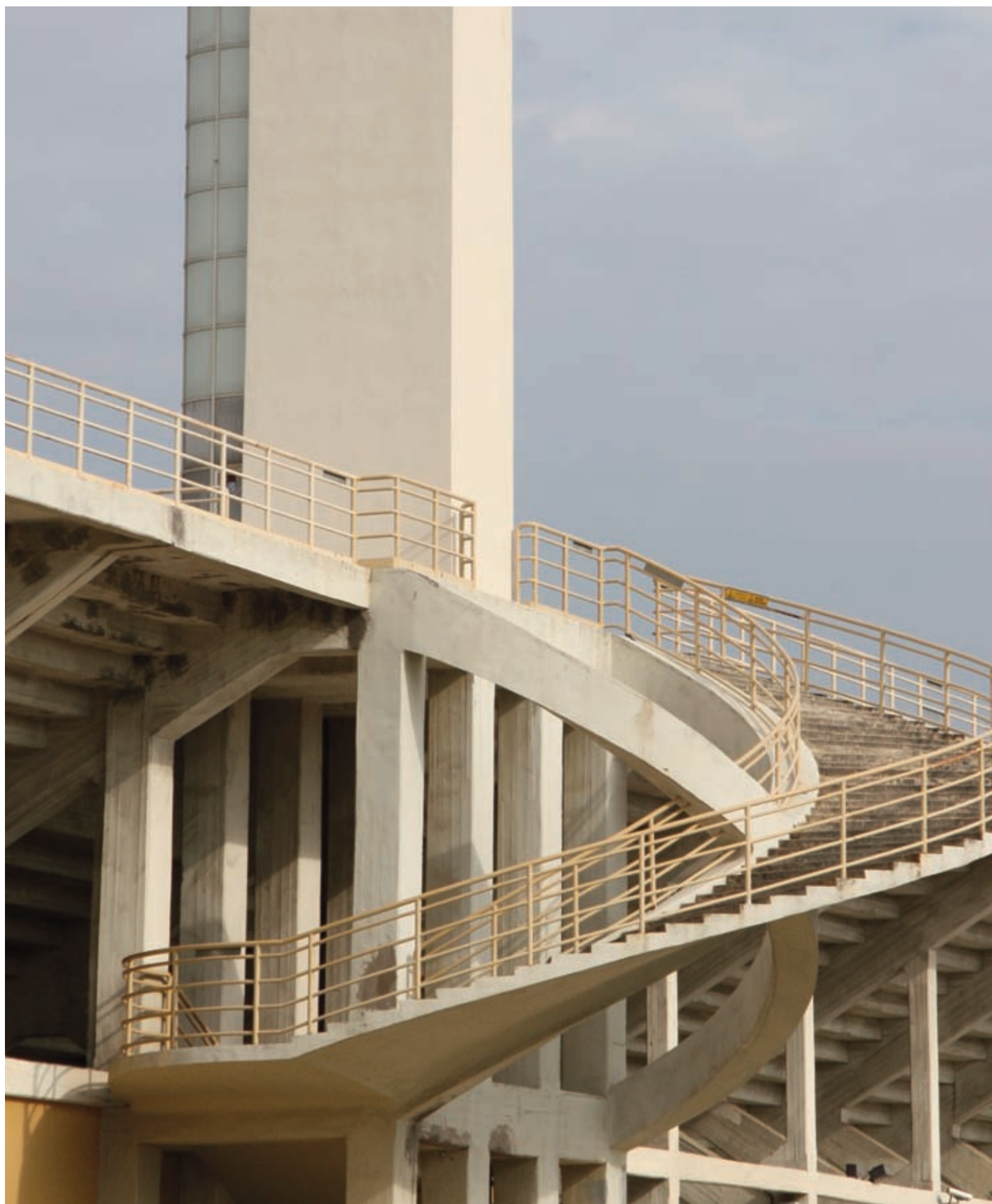
Figura 3: Veduta fotografica della rampa d'accesso alle tribune.
