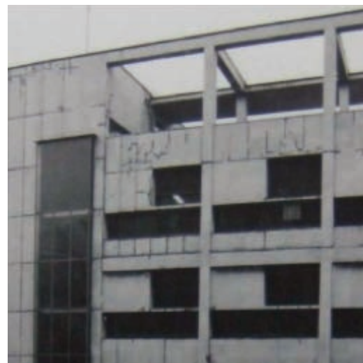
Figura 11: Il fronte principale con i degradi dovuti all'intervento antecedente al 1989 (Archivio Municipale di Como, Casa del Fascio di Como).
