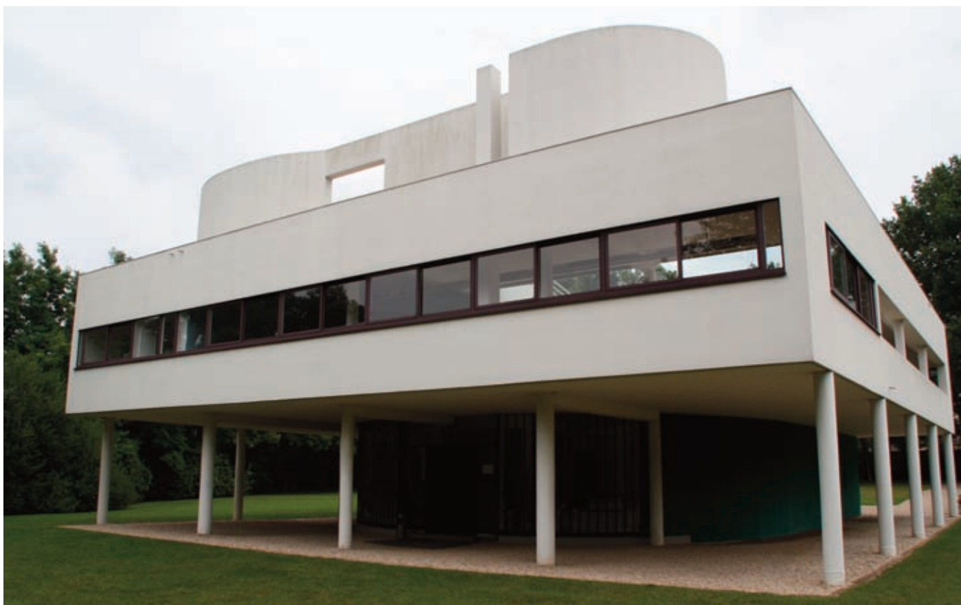
Figura 8: Villa Savoye - Vista dopo i restauri, 2010.
