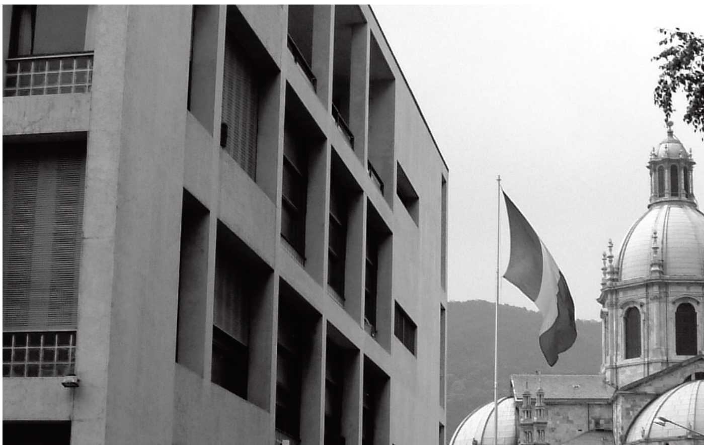
Figura 8: Vista fronte-lato nord-ovest, 2011.
