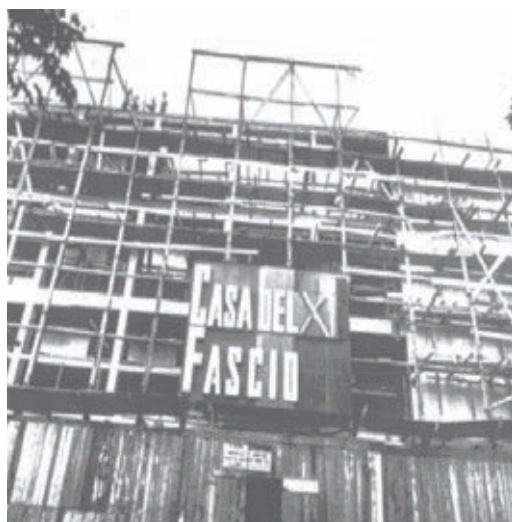
Figura 5: luglio 1933 apertura cantiere, (Archivio Municipale di Como, Casa del Fascio di Como).
