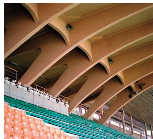
Figura 6: Studio Nervi & Nebbiosi, Stadio Comunale Giovanni “Artemio Franchi”, Pensilina, 1930-32, Firenze. La pensilina di copertura (Archivio fotografico Comune di Firenze).
