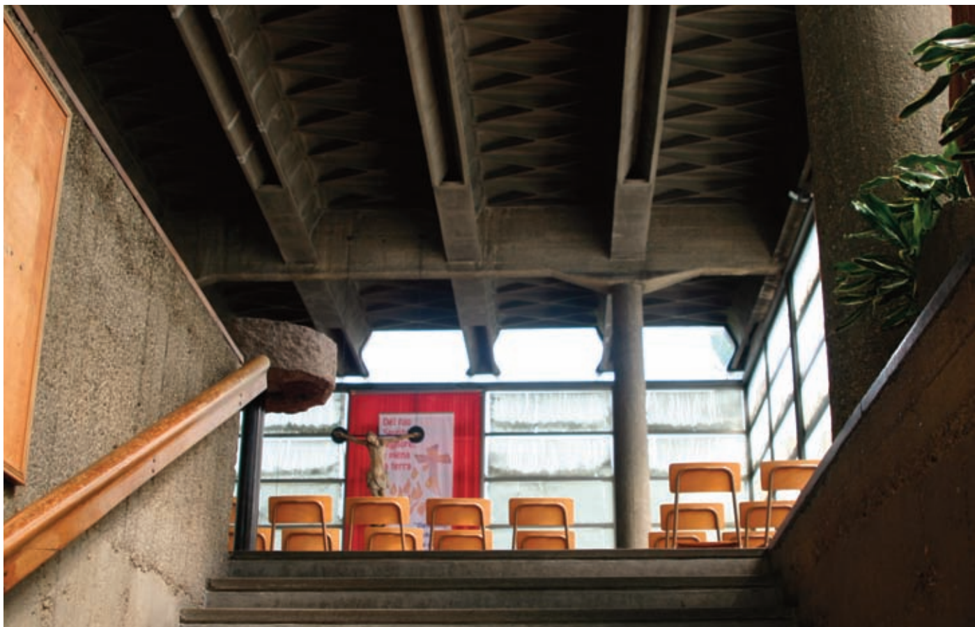
Figura 11: La rampa d'accesso al piano rialzato della chiesa, 2011.
