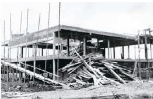
Figura 3 : Le Corbusier, Villa Savoye , In costruzione, Poissy, France, Estate 1929 (Archivio Fondazione Le Corbusier).
