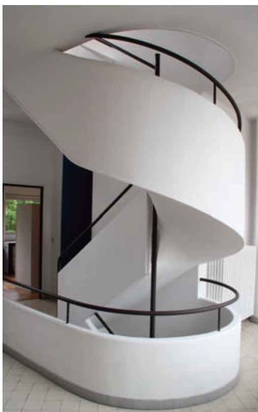
Figura 11: Villa Savoye - Vista dopo i restauri della scala d'accesso ai piani superiori, 2010.
