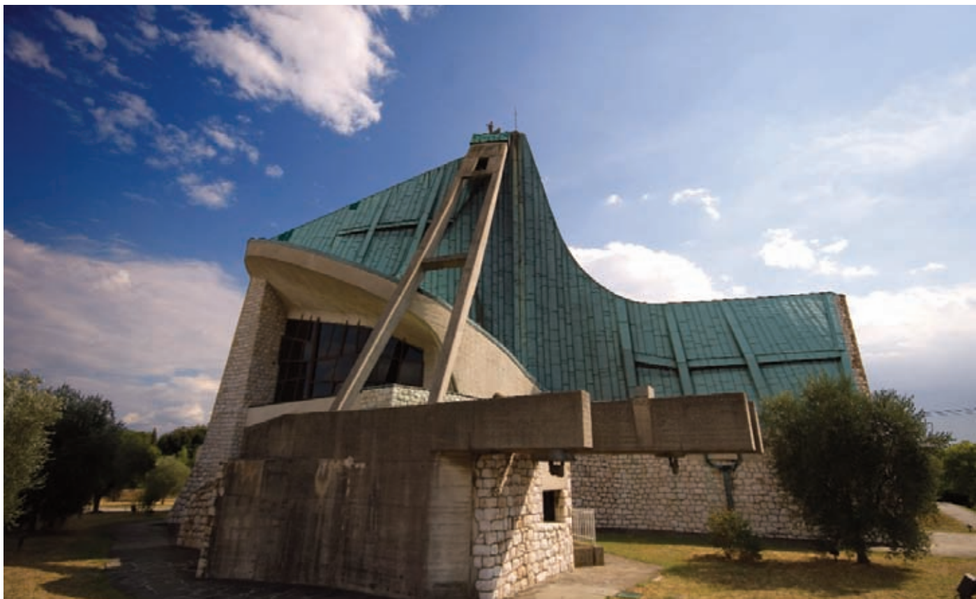
Figura 21: Chiesa dell'autostrada (Archivio Fotografico - Fondazione Michelucci).
