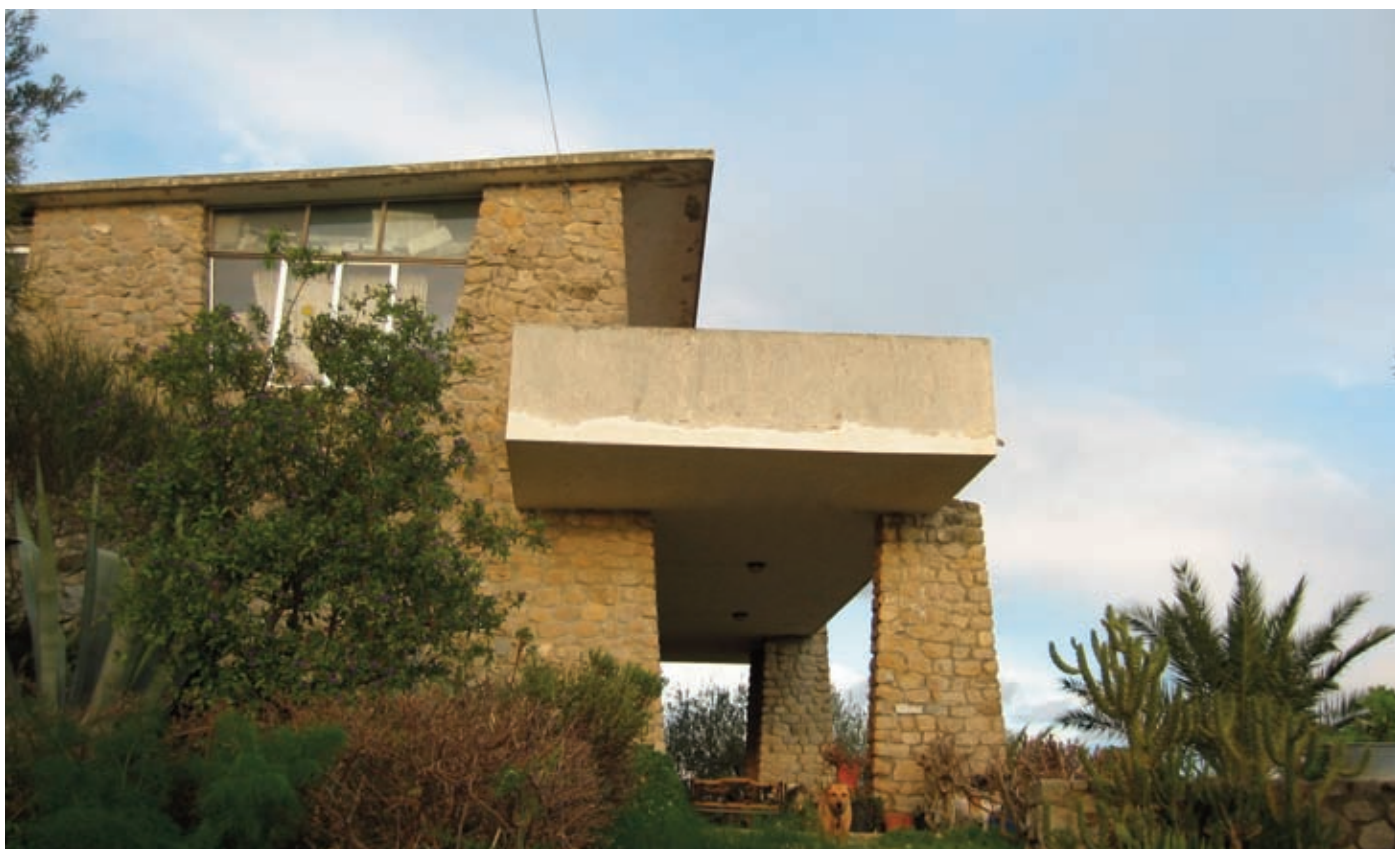
Figura 2 : Vista laterale della Casa per ferie oggetto di un progetto in fase di stesura.
