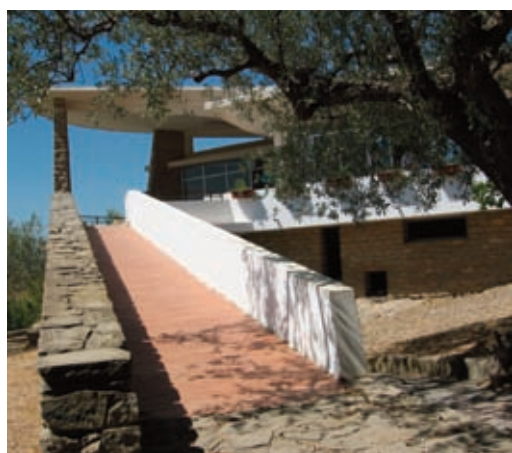
Figura 41: Asilo, particolare della rampa d'accesso al terrazzo.
