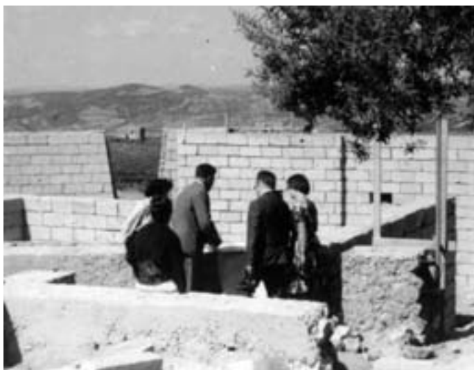
Figura 47: Fasi di edificazione dell'Officina meccanica, 1965. (Archivio Servizio Cristiano, Riesi).
