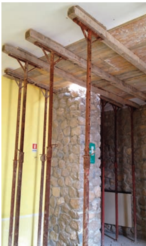
Figura 6-7 : Estradosso e intradosso del solaio del Refettorio della Scuola Elementare.
