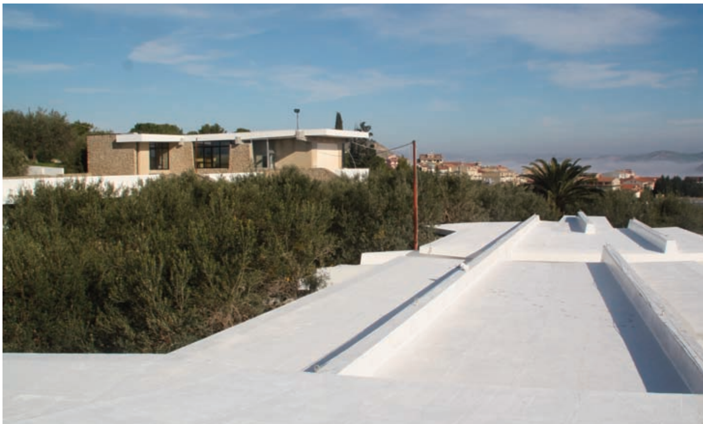
Figura 14 : La copertura della Scuola Materna dopo l'intervento di manutenzione straordinaria.
