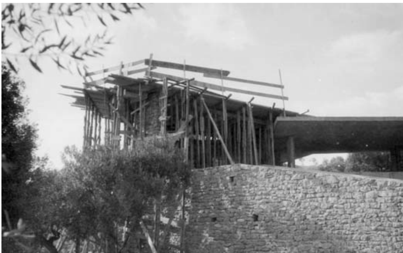
Figura 7: La costruzione del solaio di copertura della Scuola Materna. (Archivio Servizio Cristiano, Rieti).
