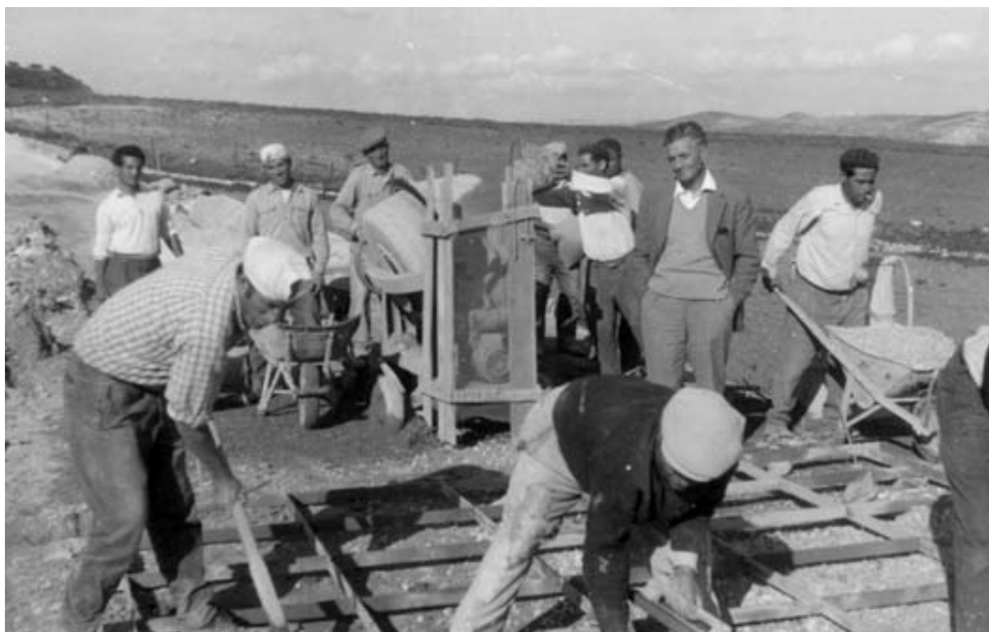
Figura 22-23: Il Pastore Valdese Tullio Vinai in cantiere durante le prime fasi di costruzione. (Archivio Servizio Cristiano, Rieti).
