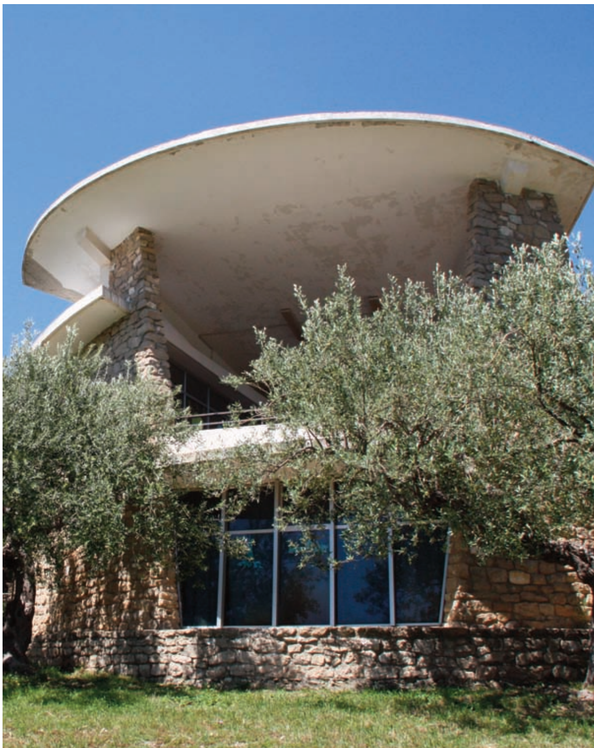
Figura 73: Scuola Materna - Vista del Fronte principale.
