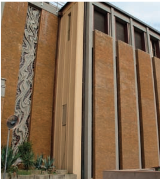
Figura 44: Spadolini Pierluigi, sede del quotidiano "La Nazione", particolare della struttura prefabbricata che ripartisce il prospetto.
