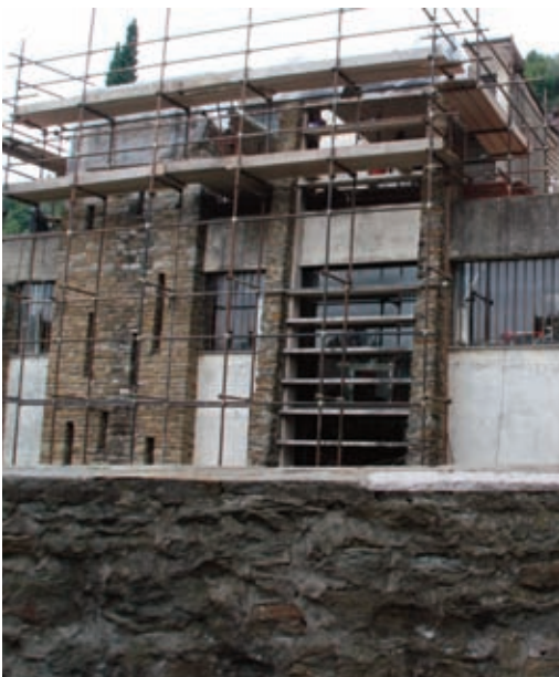
Figura 40: Leonardo Ricci, Casa-Studio di Monterinaldi, durante il cantiere di restauro, Ottobre 2010.
