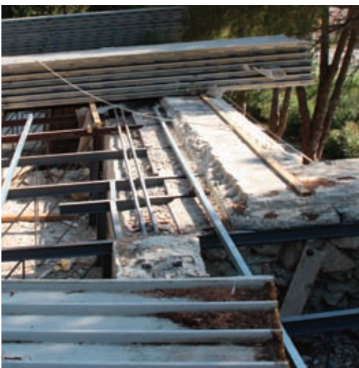
Figura 76: La Biblioteca - Vista della copertura.
