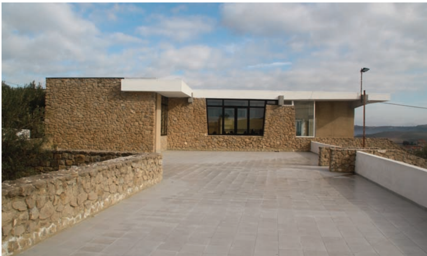
Figura 13 : La Terrazza della Scuola Elementare dopo l'intervento di manutenzione straordinaria.
