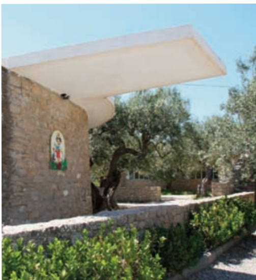
Figura 68: Scuola Materna - Vista del Fronte posteriore.
