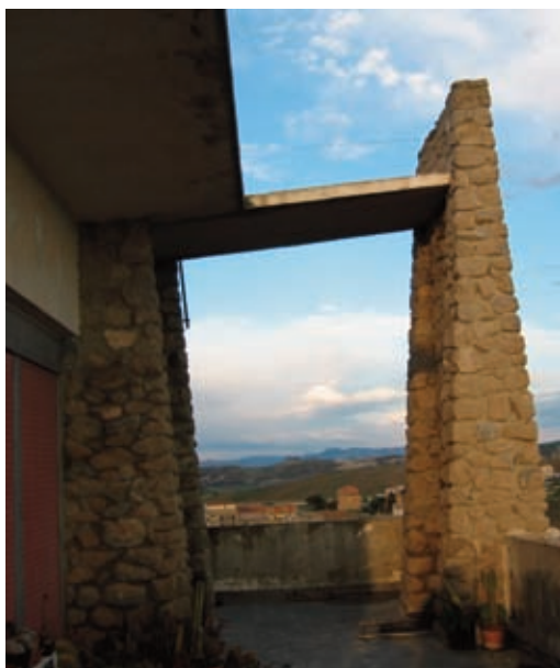
Figura 10: Particolare del terrazzo della Casa per ferie.
