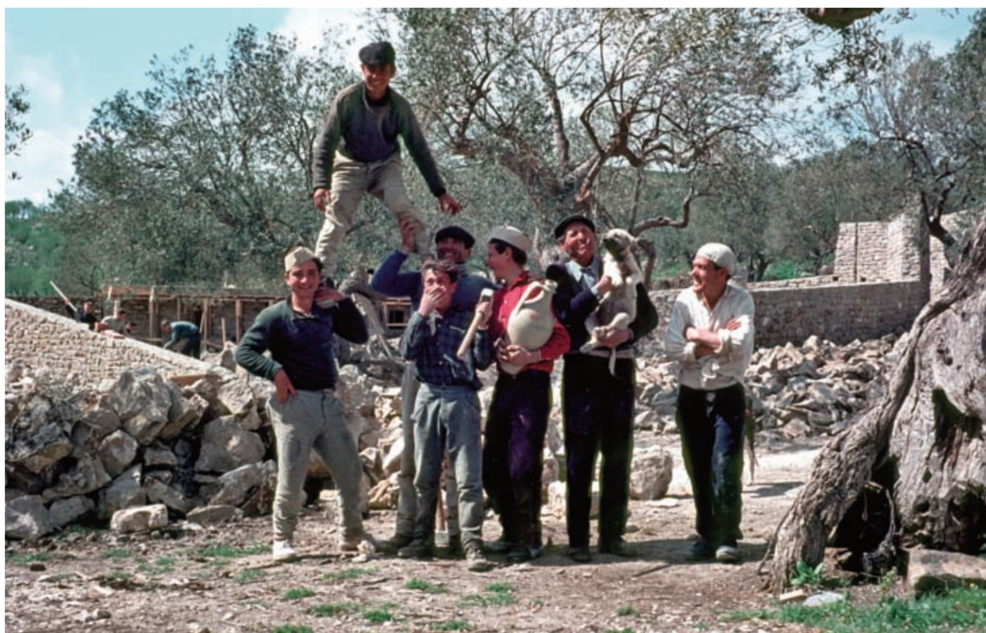
Figura 14-15: Alcune fasi di costruzione della Scuola Materna, 1963. (Archivio Servizio Cristiano, Rieti).
