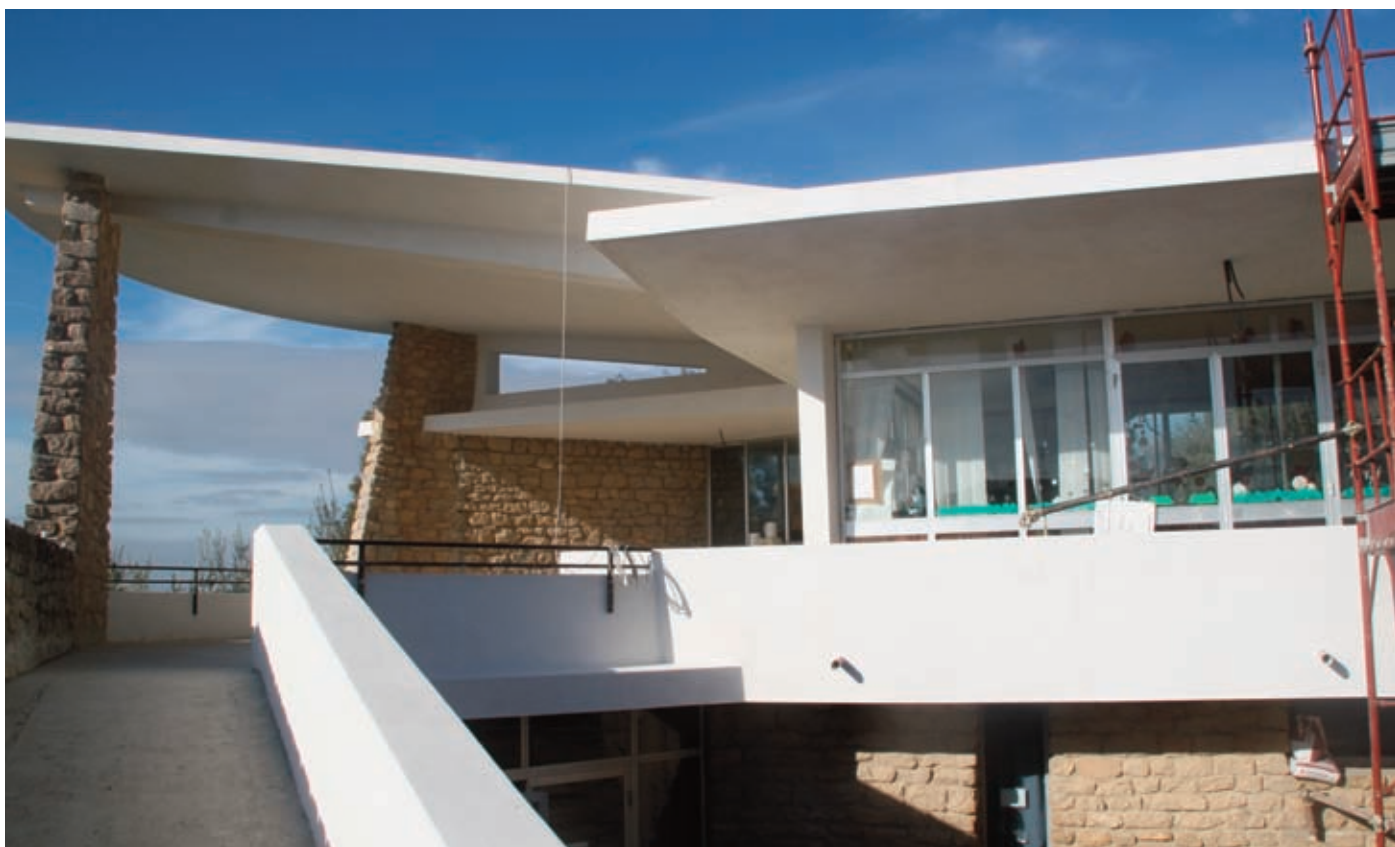
Figura 16 : La Scuola Materna dopo l'intervento di manutenzione straordinaria.
