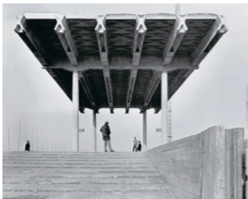
Figura 3: La struttura portante della chiesa senza il corpo di vetro 1956 (Foto Archivio Mangiarotti).
