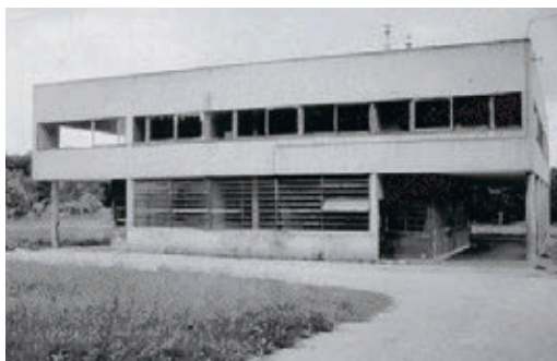
Figura 6 : Villa Savoye, prima dell'intervento di restauro (Mostafavi M., Leatherbarrow M., On Weathering: The Life of Buildings Time, MIT Press, Boston 1993).
