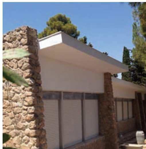
Figura 77: La Biblioteca - Vista del Fronte principale, durante i lavori di manutenzione.
