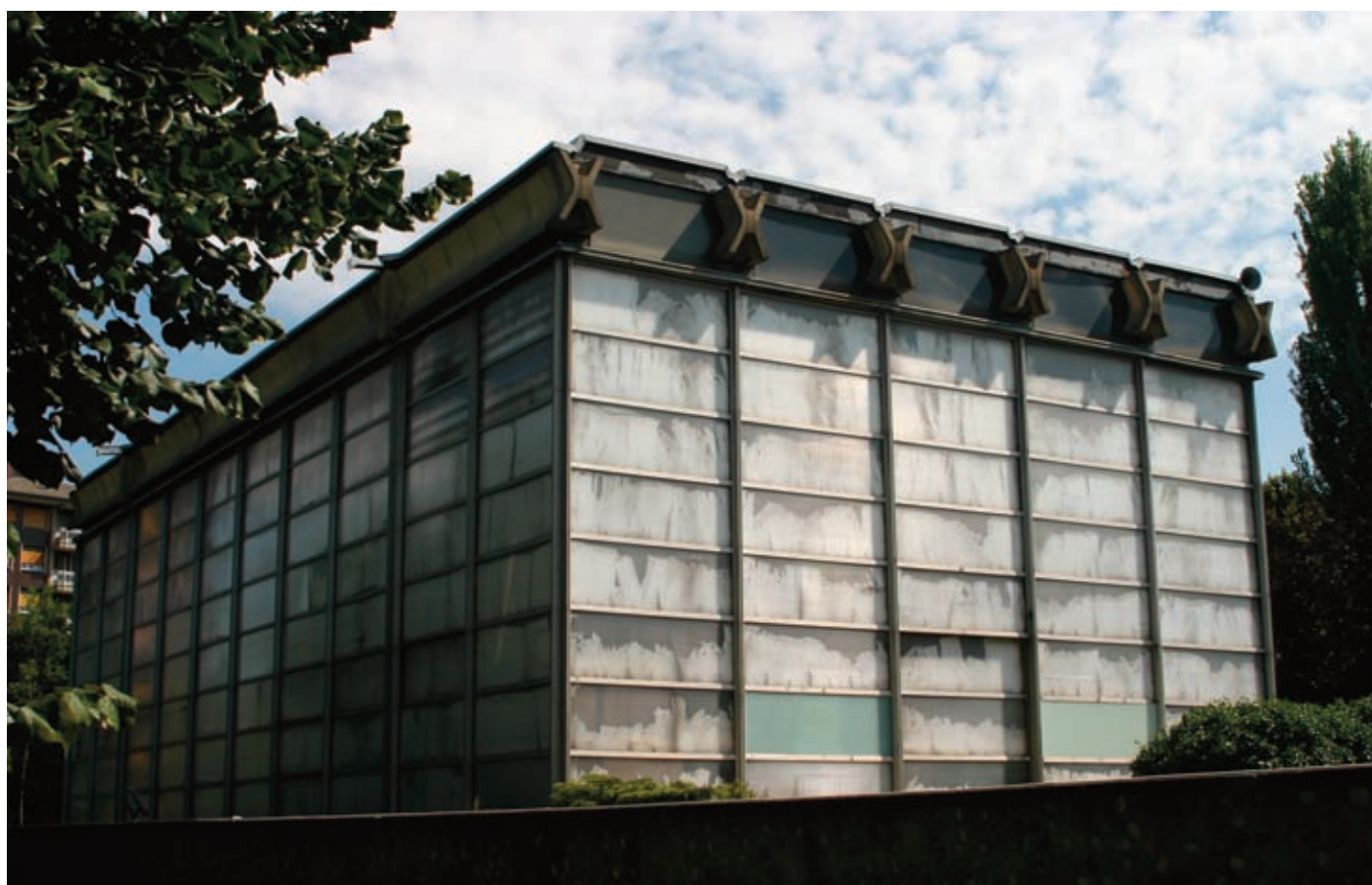
Figura 7: Veduta esterna del fronte posteriore, 2011.
