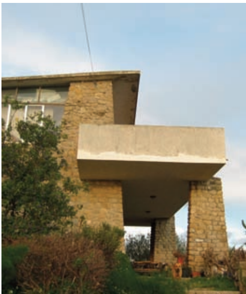
Figura 31: Particolare del terrazzo della Casa per ferie.
