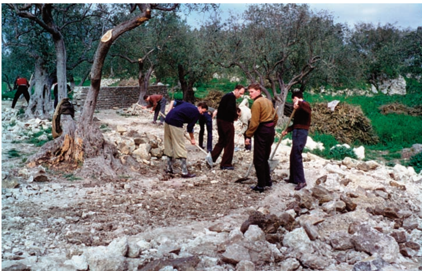
Figura 16-17: Alcune fasi di costruzione della Scuola Materna, 1963. (Archivio Servizio Cristiano, Rieti).
