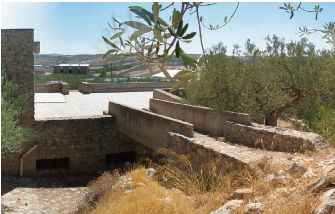
Figura 35: Particolare del retro della scuola elementare.
