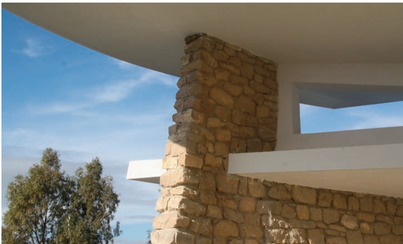
Figura 15 : La copertura del terrazzo della Scuola Materna dopo l'intervento di manutenzione straordinaria.
