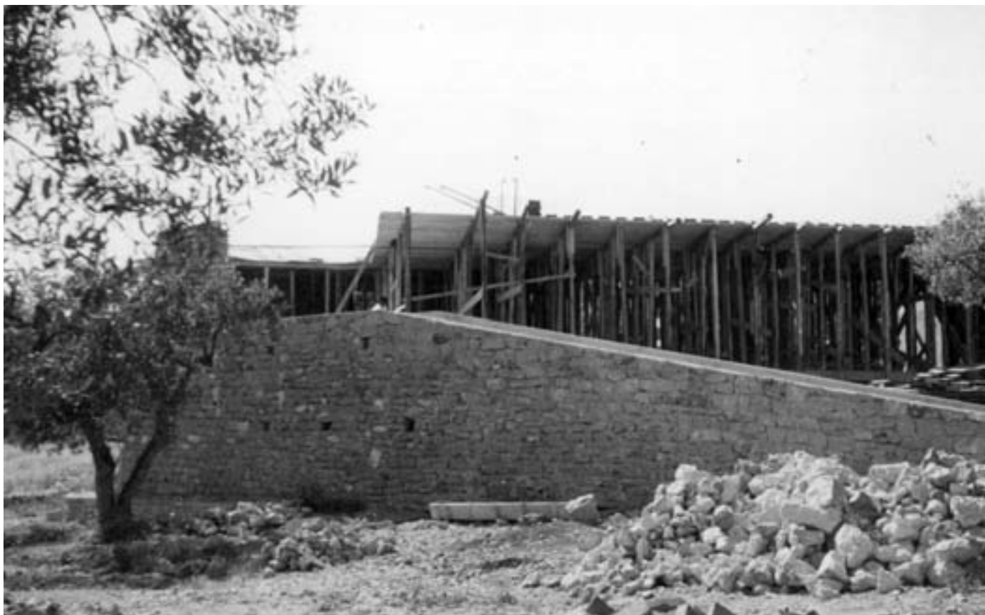
Figura 6: La costruzione del solaio di copertura della scuola Materna. (Archivio Servizio Cristiano, Rieti).
