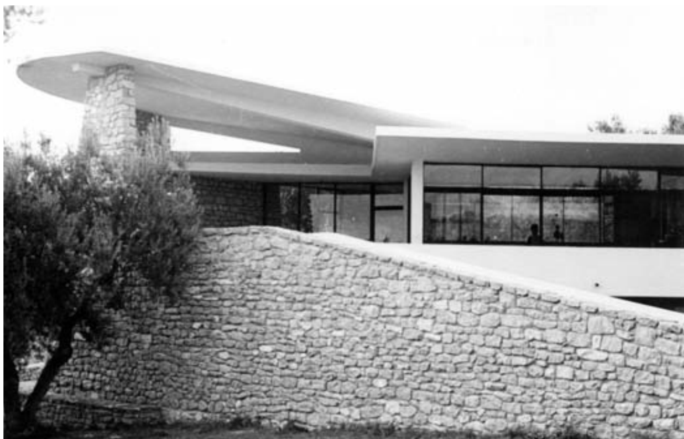
Figura 8-9: In Alto la costruzione dell'impalcatura di sostegno del solaio della Scuola materna, in Basso la Scuola Materna nl 1963 a lavori conclusi (Archivio Servizio Cristiano, Rieti).
