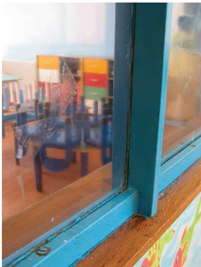
Figura 71: Scuola Materna - l'infisso interno delle aule.
