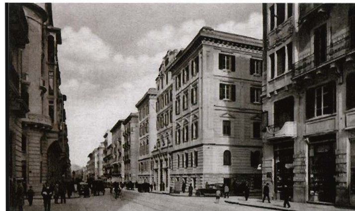
Via Roma, Palermo. Veduta del secondo tronco (1915-1922); cartolina (coll. Mauro-Sessa, Palermo). Sulla sinistra palazzo Napolitano (S. Caronia Roberti, 1923); sulla destra palazzo Caputo-Pirrotta (R. Milazzo, 1924). Palazzo delle Ferrovie dello Stato (T. Lo Cascio, 1930), palazzo Ajroldi-Rutelli (E. Basile, 1922), palazzo Prestana (V. Alagna, 1923)
