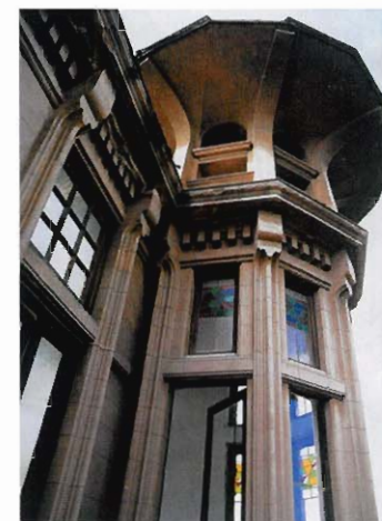
III.1.11 Villino Caruso-Valenti, via Dante 159, Palermo, F. La Porta 1906-1908. Gradini di invito dello scalone ligneo (F. Scianca, 1971)
