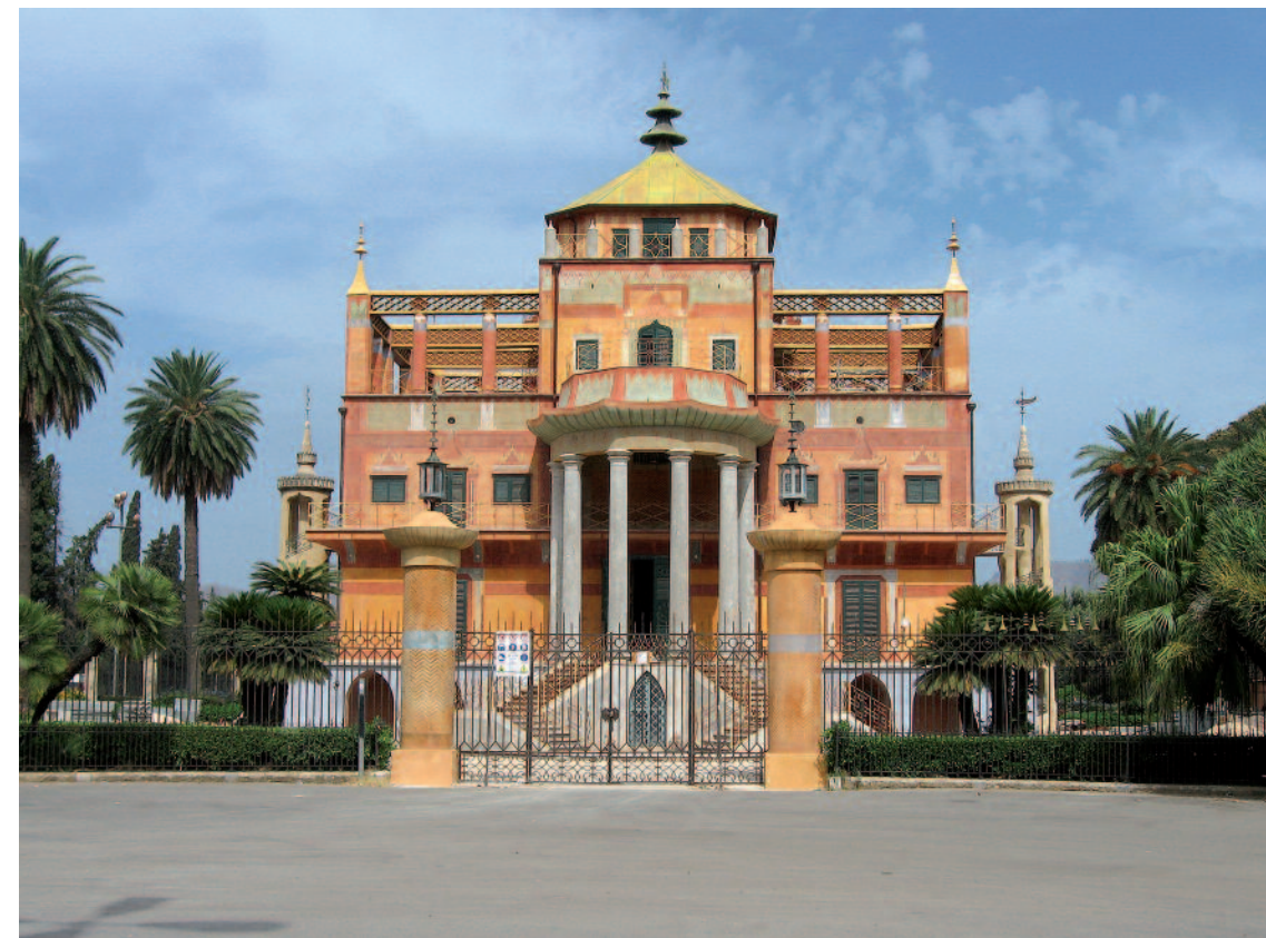
La Palazzina Cinese dopo il restauro dei prospetti.
