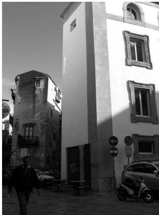
La facciata su via dell'Università, a restauro ultimato.
