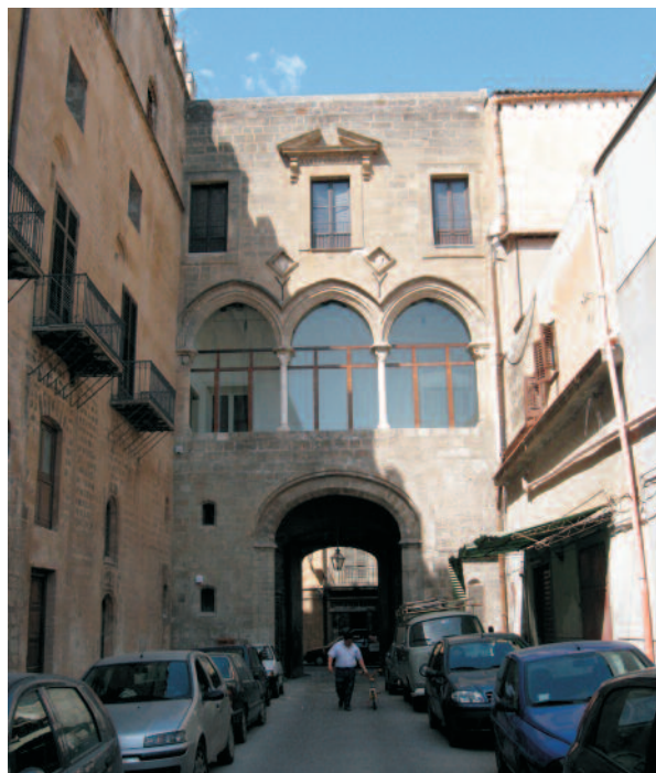
Il Palazzo Ajutamicristo: il loggiato sul corpo aggiunto ripristinato.
