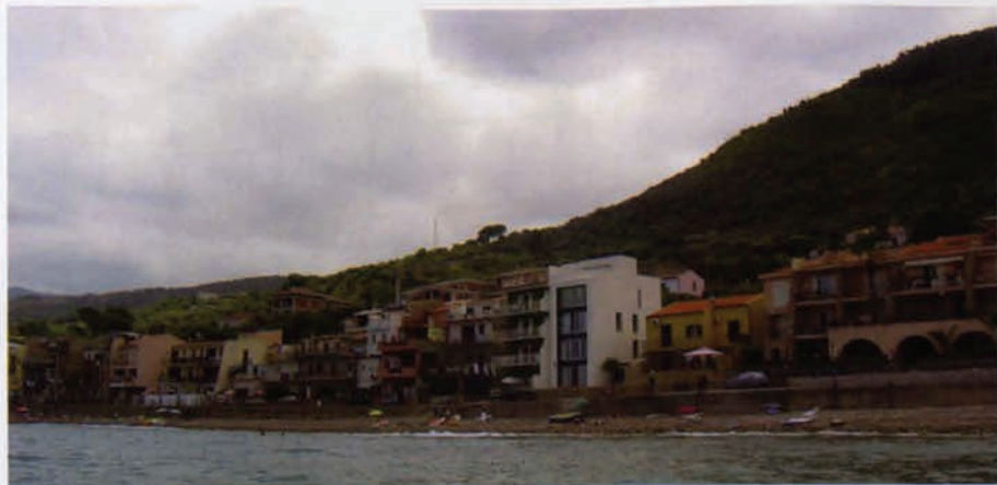
Qui e a seguire: Caronia Marina, 2002-2005, edificio per abitazione bifamiliare
