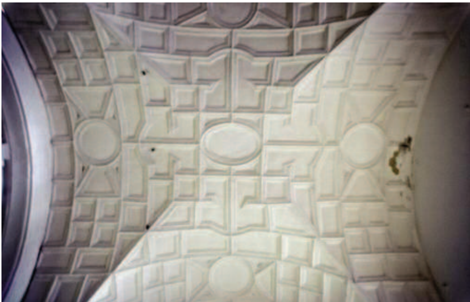
Fig. 7 Convento di San Domenico. Cappella di Santa Barbara, veduta della volta di copertura a crociera ribassata decorata con geometrie astratte
