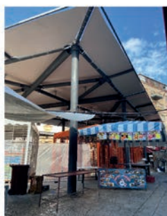
4. Struttura metallica vuota con cartelli
