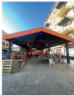
7. Struttura coperta del mercato
