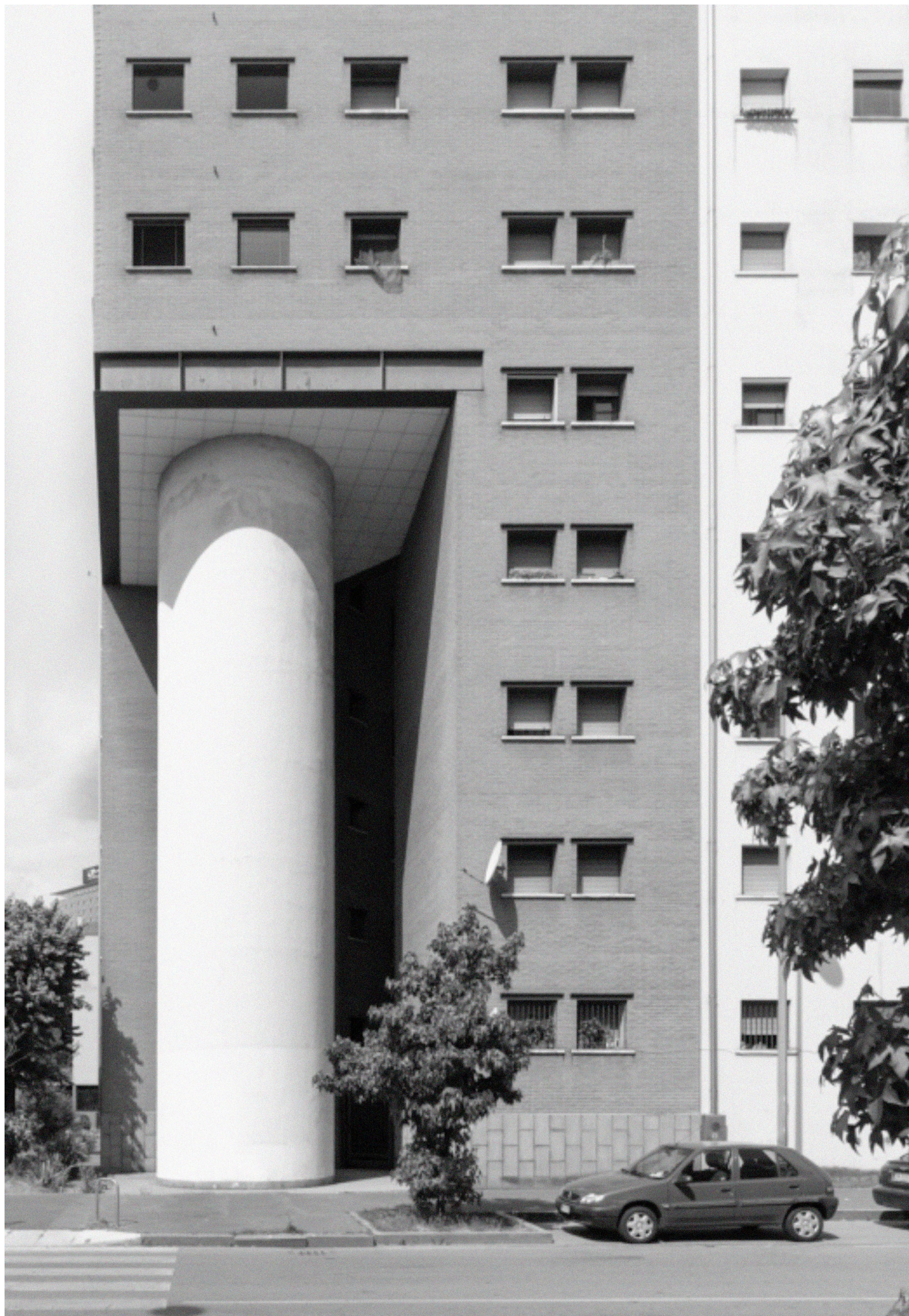
Fig. 28.b - Marco Introini (foto di), Edificio residenziale in zona Vialba – Dettaglio della grande colonna d'angolo – Aldo Rossi, s.d.;
