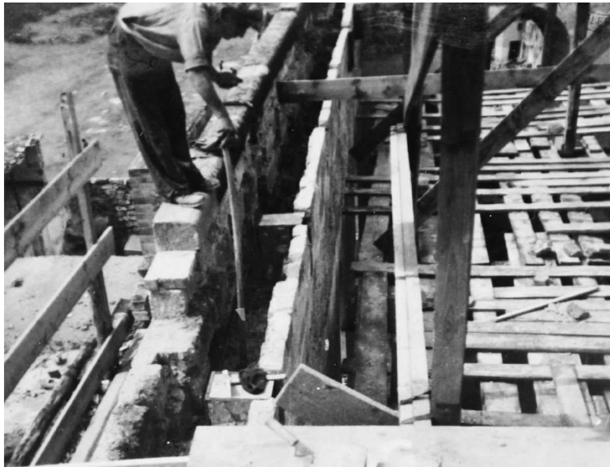
Fig. 10 - Basilica della Santissima Trinità del Cancelliere a Palermo. Realizzazione di un cordolo in calcestruzzo armato tra i due paramenti murari in occasione dei lavori di restauro del 1944 (© SBC Palermo)
