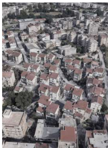
Fig. 2.16 Il Quartiere Modena di Reggio Calabria, oggetto della sperimentazione.
