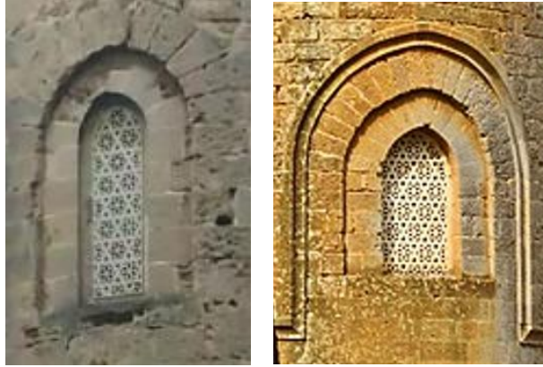
Figure 117. Curve windows on the apses of San Giovanni dei Lebbrosi and Santissima Trinità.
