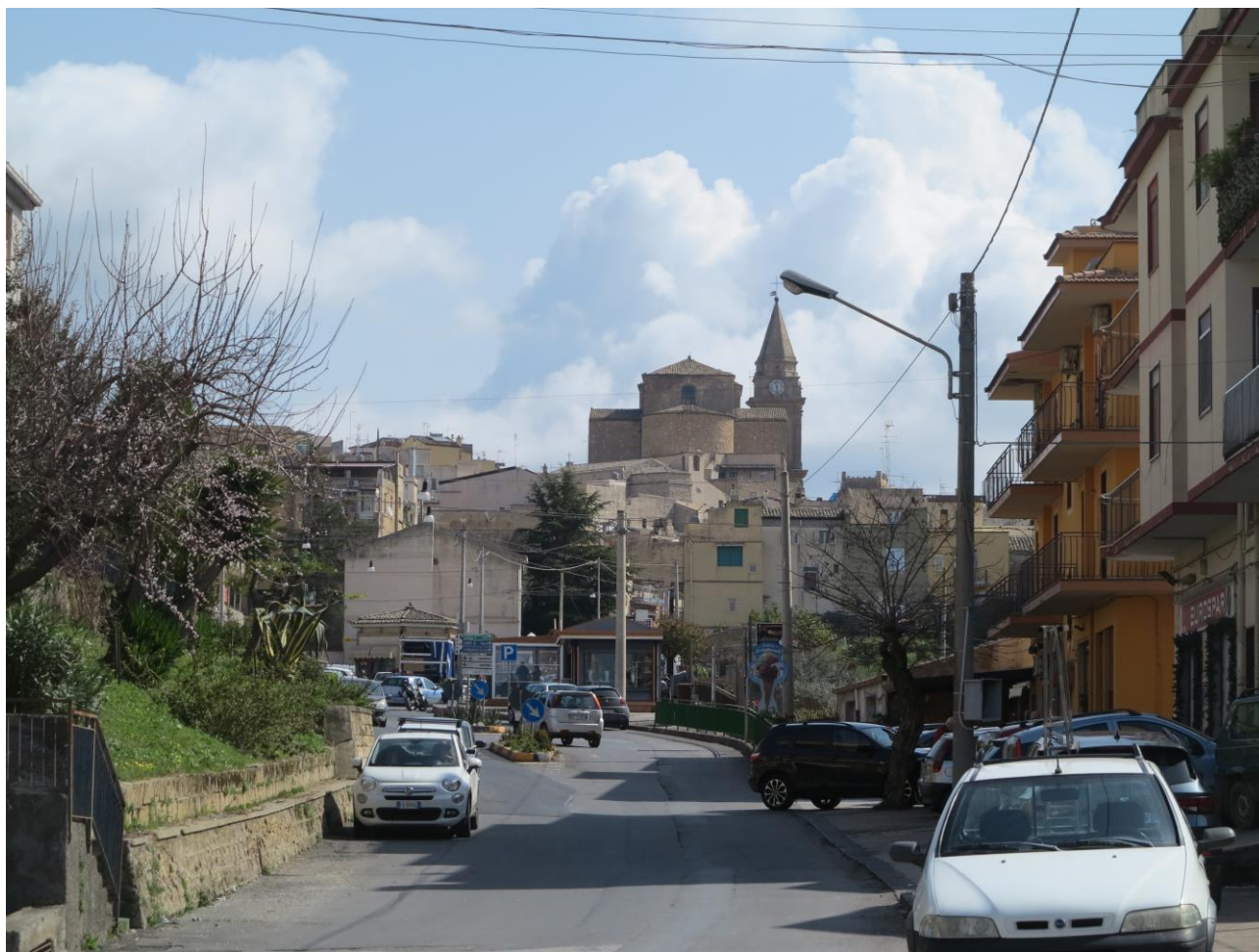
Figura 122. I volumi della chiesa madre e del campanile con l'orologio civico visti dalla strada settentrionale verso Troina.
