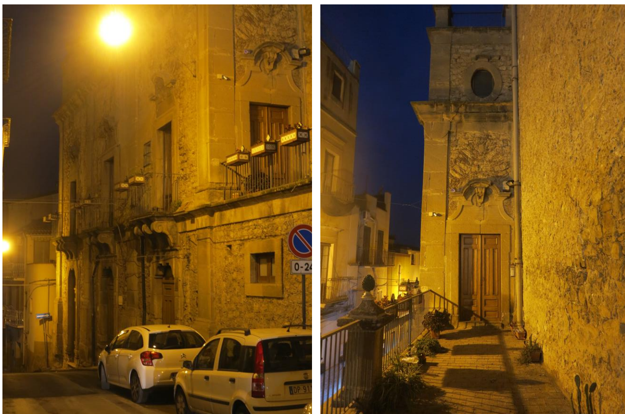
Figure 118-119. Chiesa madre di San Basilio. Corpo della nuova sacrestia lungo la strada laterale e accesso dalla terrazza esterna.
