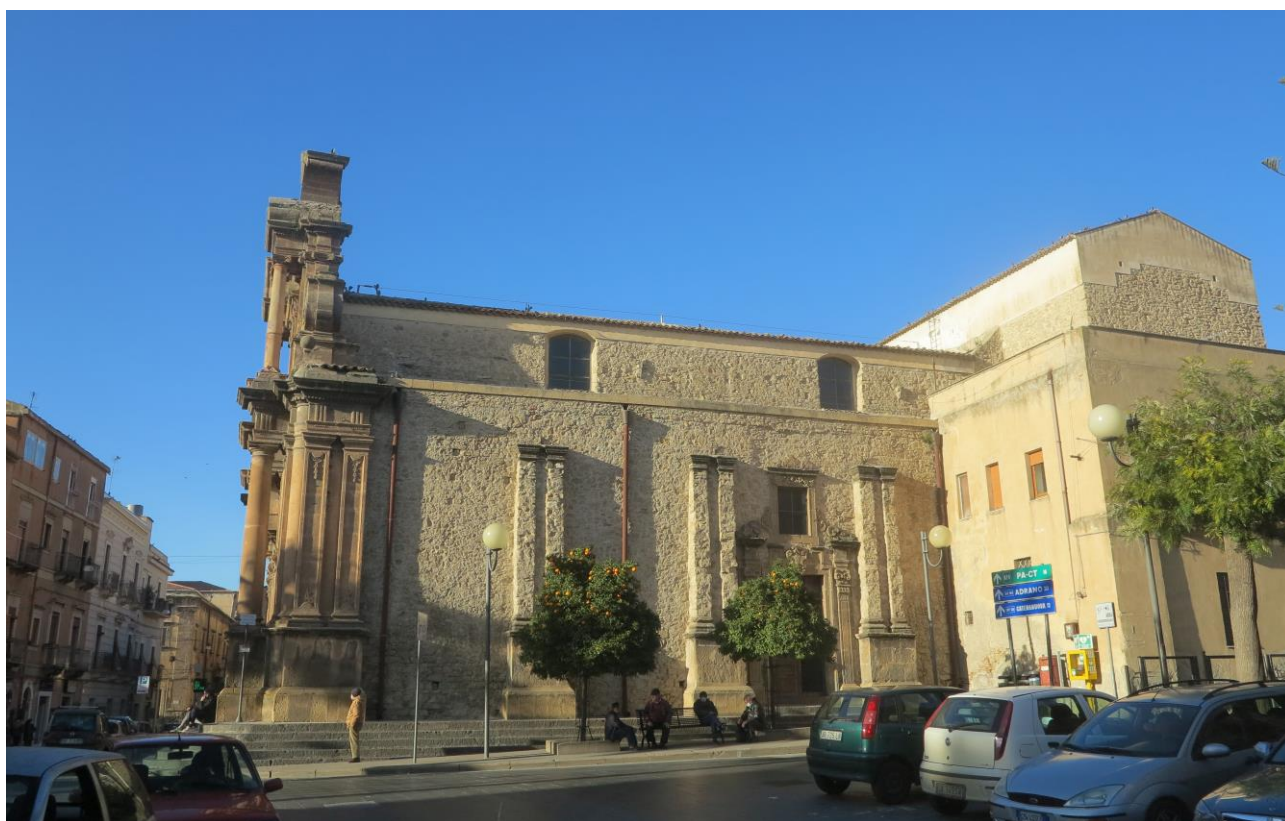
Figura 47. Chiesa di Santa Maria delle Grazie Veduta del fianco laterale allo stato attuale.
