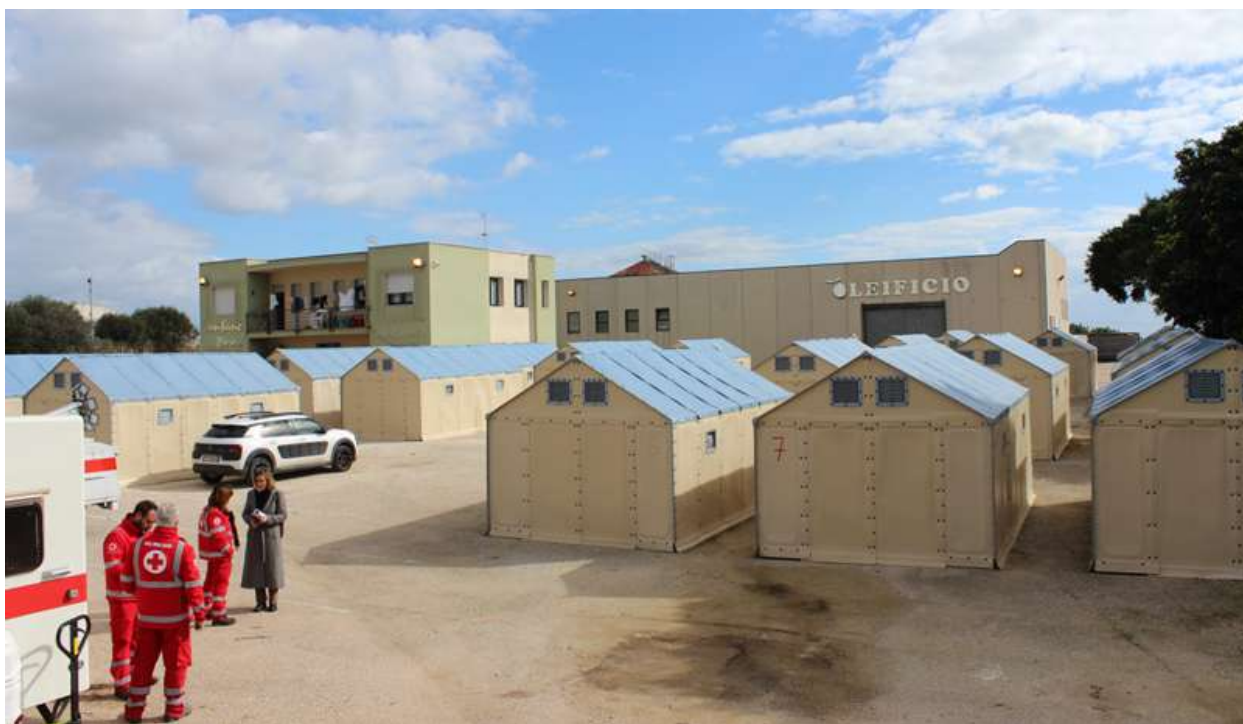
Figura 4.4.7 Moduli abitativi IKEA all'interno del campo lavoratori stagionali di Campobello di Mazara: soluzioni temporanee progettate per garantire funzionalità e comfort essenziali in contesti emergenziali
