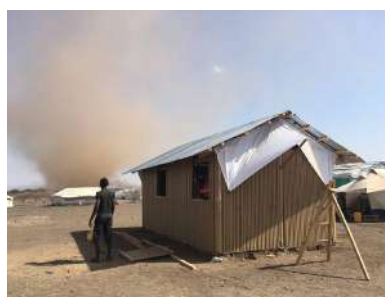
Figura 2.1.1c.12 Realizzazione sistema di ventilazione ©UNHABITAT
