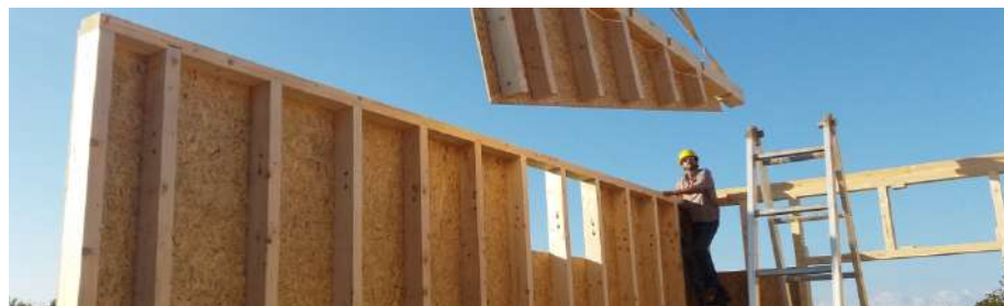
Fig. Realizzazione costruttivo a telaio dell'azienda
