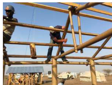
Figura 2.1.1c.10 Cantiere Typea ©UNHABITAT
