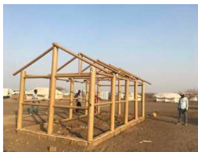
Figura 2.1.1c.10 Realizzazione struttura portante ©UNHABITAT
