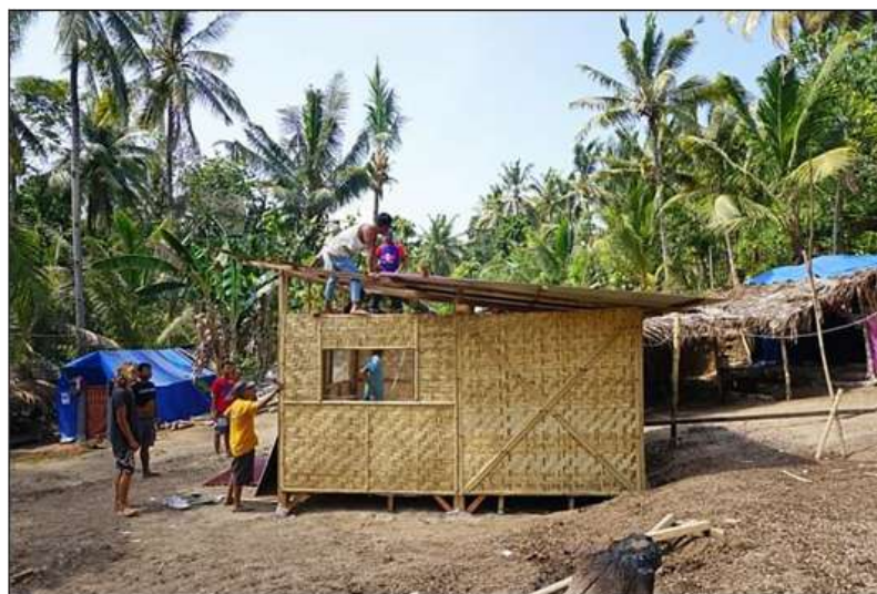
Figura 3.1.2 Lombok Shelter: rifugio temporaneo realizzato con materiali naturali locali e tecniche costruttive semplici. Il progetto valorizza l'impiego delle risorse disponibili sul territorio, promuovendo soluzioni sostenibili e partecipative in contesti emergenziali.
