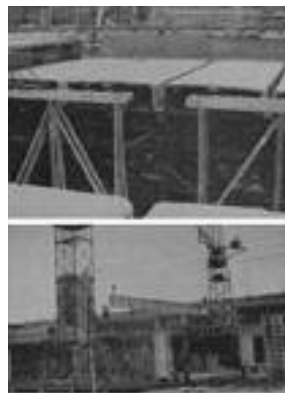
Il cantiere dell'impresa Nervi & Bartoli durante la costruzione del nuovo ampliamento nord nello stabilimento di Mirafiori, 1955. In alto è visibile il sistema di costruzione dei solai, con le forme in ferrocemento e il ponteggio mobile brevettato da Nervi (da "Prefabrication" nel 1957).
