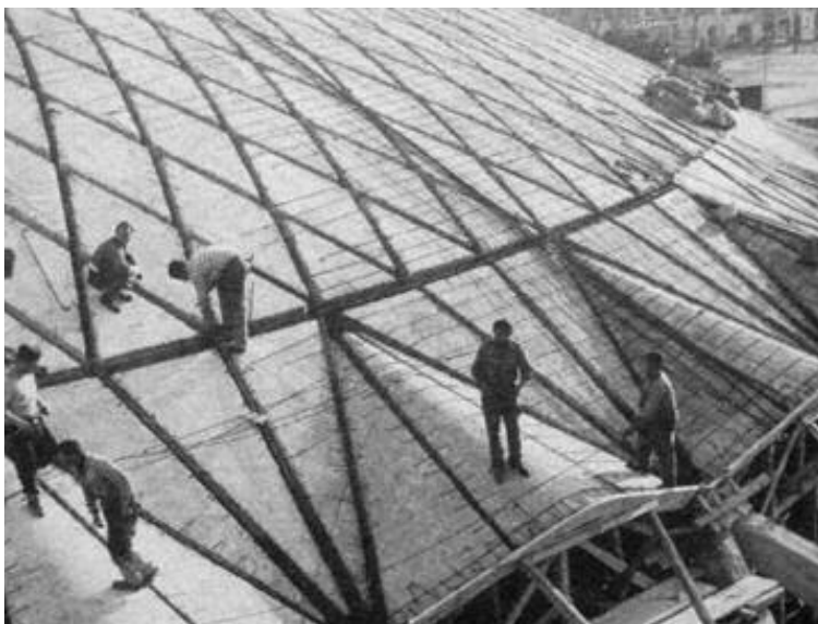
Dettaglio di cantiere della copertura del Palazzetto dello sport di Roma (Archivio Desideri).
