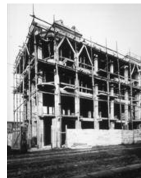
Casa Marangoni a Torino (1903-1904), in fase di costruzione (Archivio Porcheddu).
