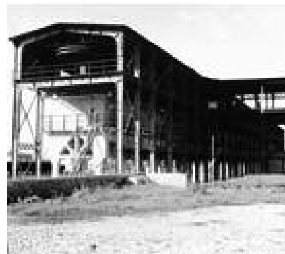
Immagini d’epoca: della stazione di carico del calcare, allo stabilimento Solvay di San Vincenzo (LI); delle tramogge di carico (Archivio Solvay, L. Gattini, A. Pastacaldi, R. Pardini).
