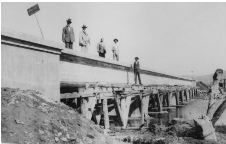
Cantiere del ponte in cemento armato sull'Albegna presso Orbetello, in costruzione da parte della Società Anonima per Costruzioni Cementizie (1914). Nel primo uomo sulla sinistra in giacca e papillon è forse riconoscibile un giovane Pier Luigi Nervi (Archivio Bianchini, presso l'Archivio di Stato di Firenze).
