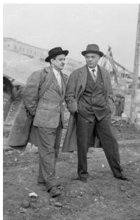
Pier Luigi Nervi e Annibale Vitellozzi sul cantiere del Palazzetto dello sport a Roma, novembre 1956 (Esposito/Publifoto Roma – Archivio Csac).
