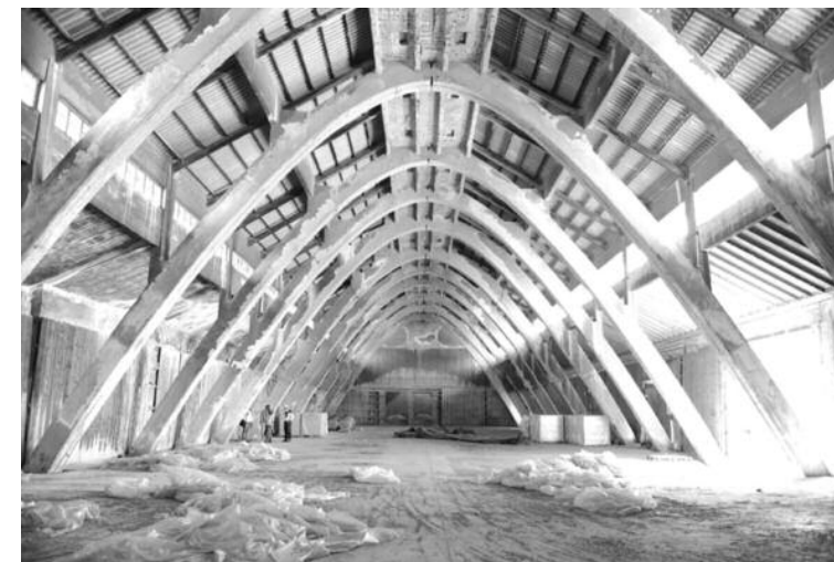
Veduta dell'interno del corpo iniziale del magazzino (foto F. Armillotta 2009).
