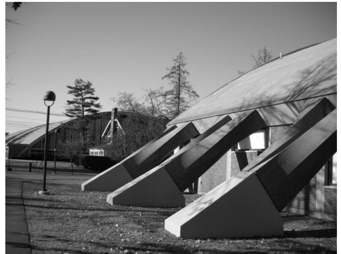
Visuale complessiva dei due edifici (foto Bologna).
