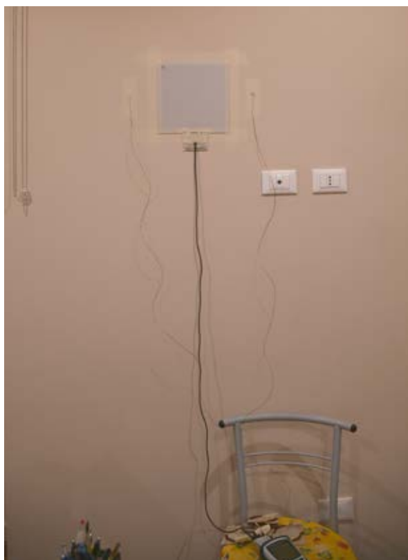
Fig. 4.20 Applicazione dei sensori nella parete interna del muro a Petralia Sottana.
