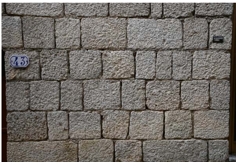
Fig. 6. 3 Foto di una muratura di tipo SM1.
