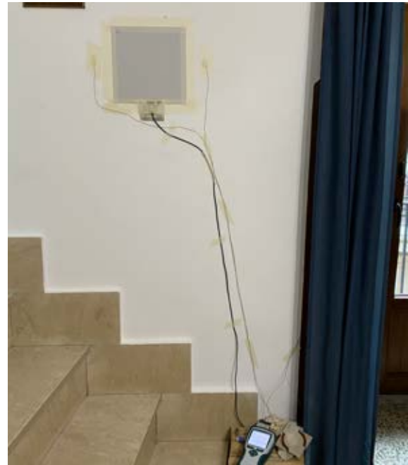
Fig. 4.37 Applicazione sensori di temperatura su muratura esterna a Geraci Siculo.
