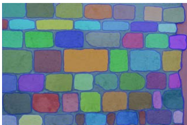
Fig. 6. 13 Immagine segmentata della muratura di tipo SM1 con Meta AI Segmentation.
