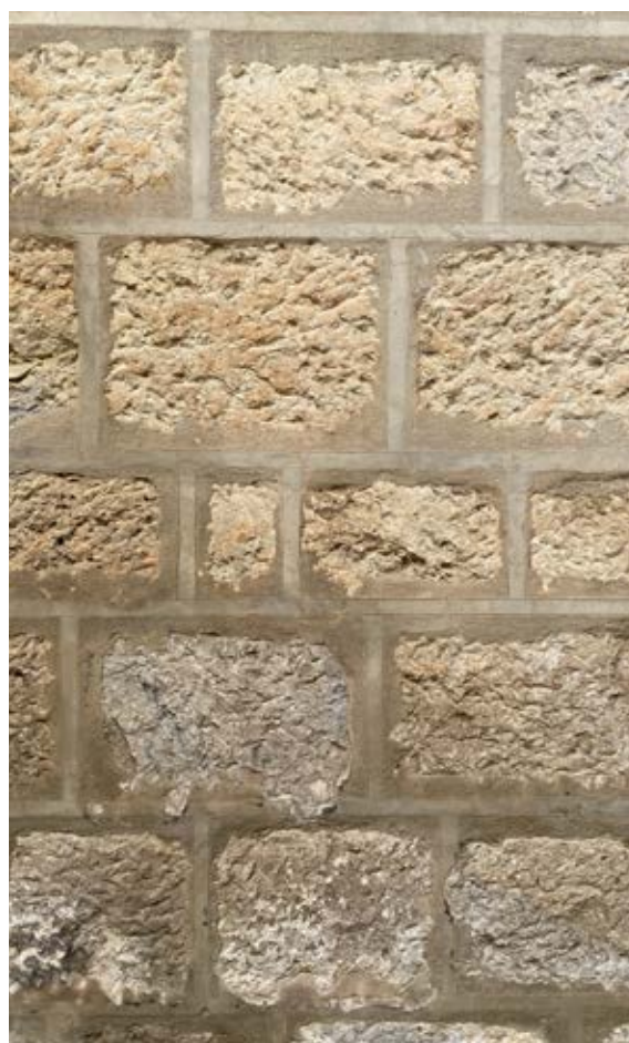
Fig. 4.32 Muratura esterna di tipo SM2.1 a Petralia Sottana.
