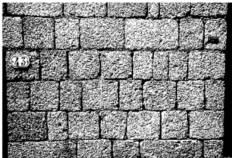
Fig. 6. 4 Foto della muratura SM1 trasformata in immagine binaria attraverso la sostituzione dei valori dei pixel in bianco e nero.
