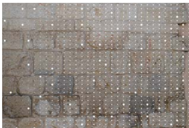
Fig. 6. 12 Elaborazione dell'immagine della muratura di tipo SM1 con Meta AI Segmentation.
