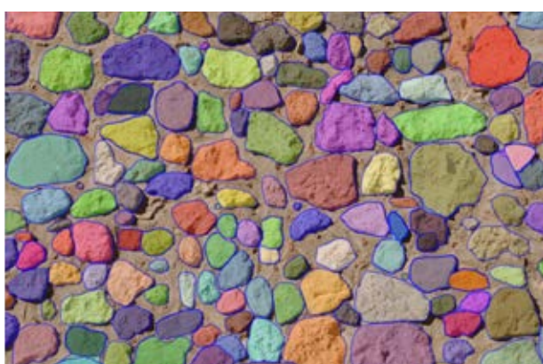
Fig. 6. 11 Immagine segmentata della muratura di tipo SM3 con Meta AI Segmentation.
