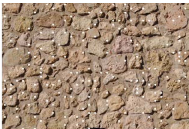
Fig. 6. 10 Elaborazione dell'immagine della muratura di tipo SM3 con Meta AI Segmentation.
