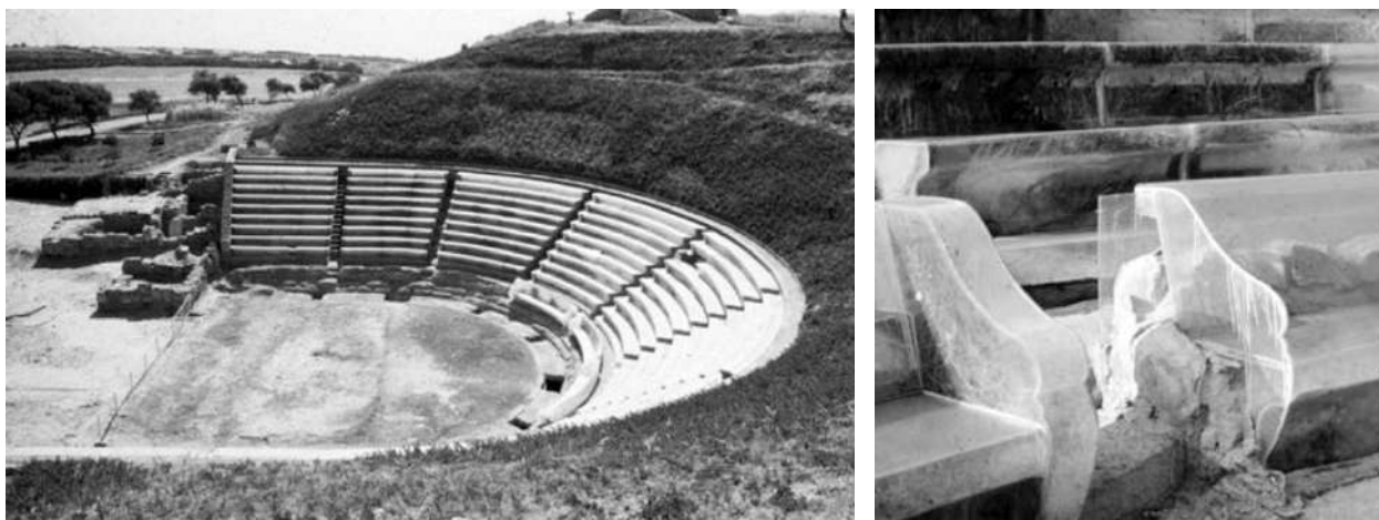
Figg. 3-4. Eraclea Minoa, veduta del teatro con i sedili ricoperti dai gusci protettivi di perspex ideati da Franco Minissi e, a destra, una vista ravvicinata che evidenzia l'ingiallimento del laminato plastico e la proliferazione biologica (foto F. Tomaselli, 1979).
