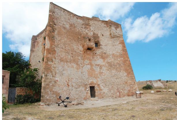
Torre della Tonnara di Cofano. Foto di Esculapio via Wikimedia commons
