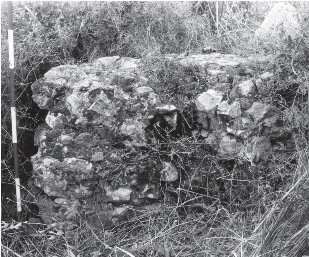
Figure 11 – L'acquedotto: struttura in situ .
