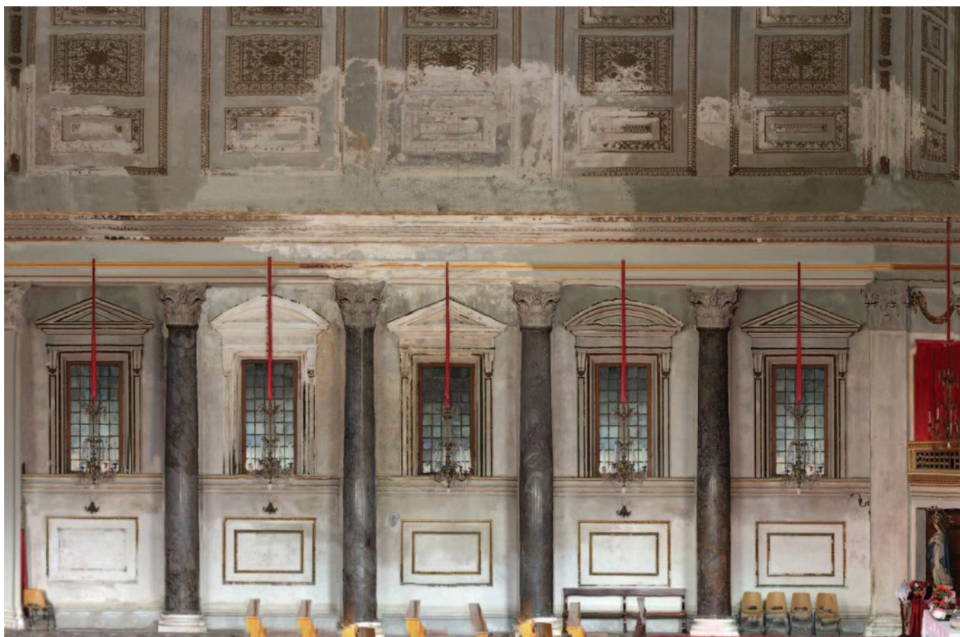
Fig. 4. Palermo, oratorio San Filippo Neri, 1763-69, veduta della parete dell'aula (foto raddrizzamento).
