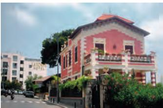
meno del muro d'attico scalettato della copertura (a terrazza); il piano terra è fasciato nell'intera costruzione da un paramento in pietra ad *opus incertum*.
