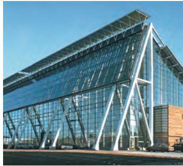
Fig. 1.2 - Ventilazione libera mediante ala di Venturi nel Padiglione per fiere ad Hannover, 1999 (Herzog + Partner)
