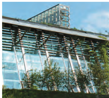
Fig. 1.3 - Camino solare in un'abitazione privata a Boston (Office dA)
