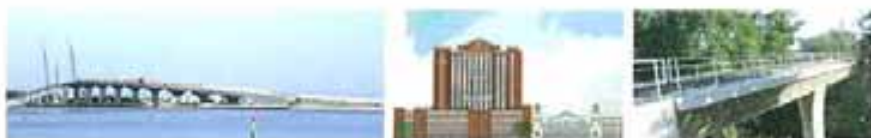
Figg. 6.1 – Alcuni edifici in cui è stato applicato l'acciaio MMFX: il Florida Department of Transportation, l'Ameristar Casino a St. Charles, il Sacramento Regional Transit District
