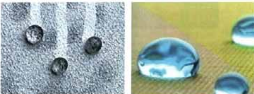
Figg. 9.7 – Le gocce di pioggia rotolano sulla superficie portandosi via anche le impurità non ben aderenti alla facciata
