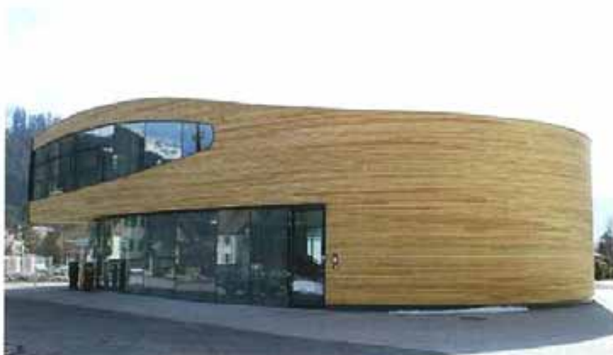
Fig. 7.1 – Esempio di un edificio con involucro esterno in legno con vernice protettiva nanostrutturata
