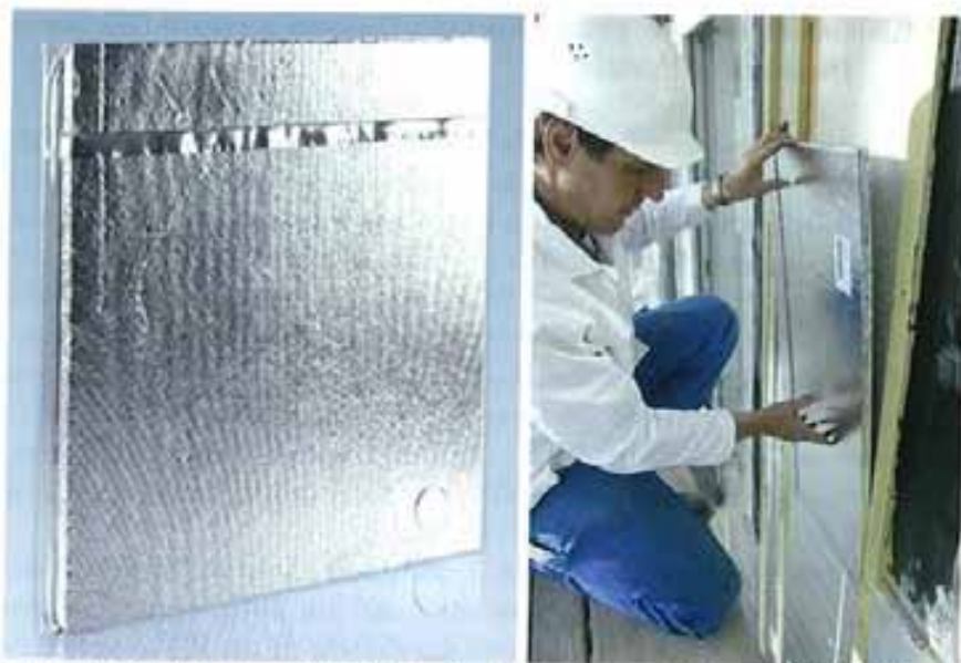
Figg. 10.10 – Il Vacuum Insulation Panels (a sinistra) e l'installazione del pannello (a destra)
