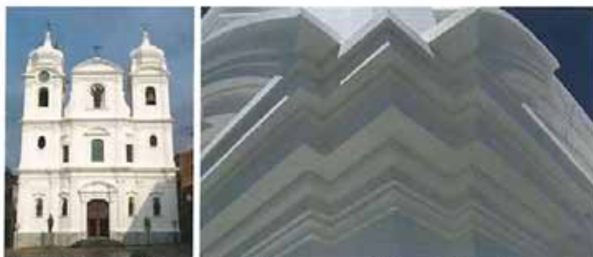
Figg. 9.14 – La Chiesa Matrice di Cittanova (RC) con il rivestimento fotocatalitico TX Active
