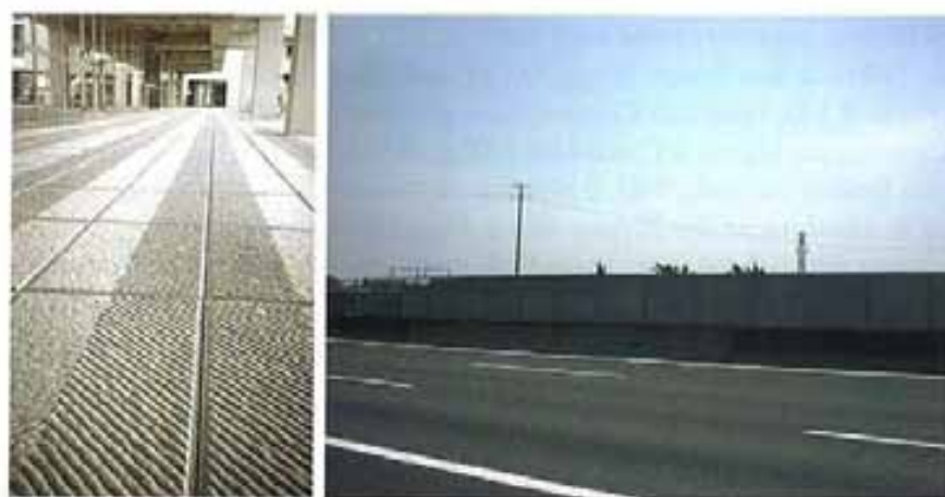
Figg. 9.12 – Pavimentazioni e barriere stradali realizzati con TX Active per combattere l'inquinamento
