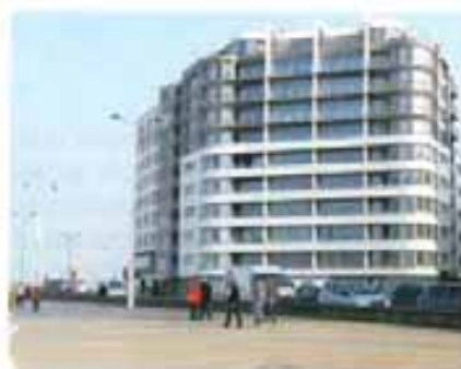
Fig. 9.15 – L'edificio The Commodore a Ostenda con il rivestimento fotocatalitico TX Active
