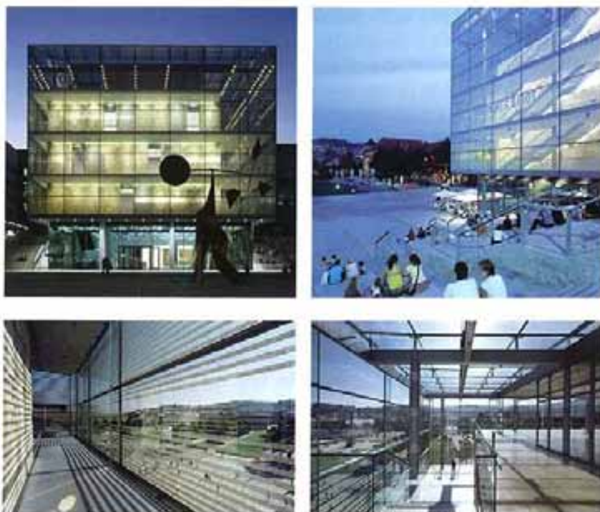
Figg. 8.7 – Hascher & Jehle Architekten: KunstMuseum a Stoccarda. Le lastre, di 4,10x2,50 metri sono formate da vetro camera multistrato di spessore complessivo di 44 millimetri con vetro di sicurezza stratificato di 10 e 8 millimetri, intercapedine riempita con argon di 16 millimetri e vetro di sicurezza temprato di 10 millimetri
