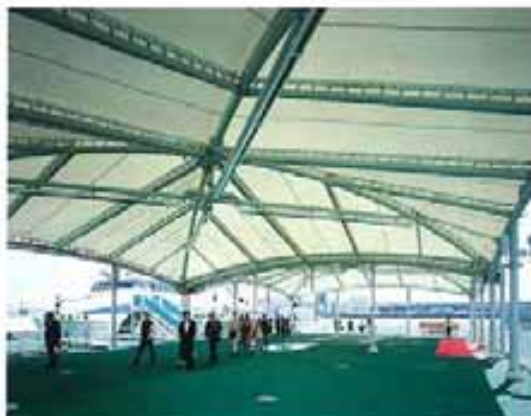
Fig. 9.19 – Membrane fotocatalitiche nel Sakurajima Floating Platform in Giappone
