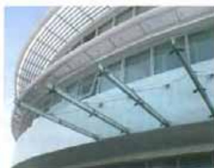
Fig. 9.16 – La sede Ciments du Maroc a Casablanca con il rivestimento fotocatalitico TX Active
