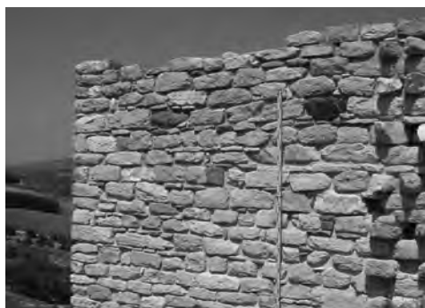
Fig. 78 - Segesta: Torre della cinta muraria superiore.
