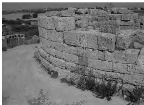
Fig. 79 - Selinunte: particolare della torre circolare.
