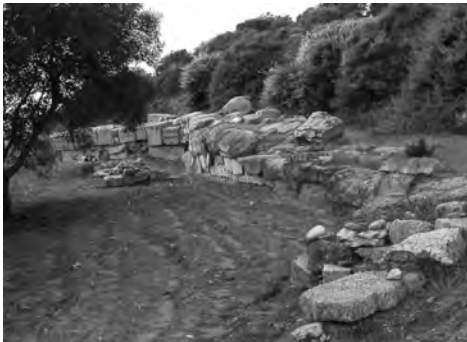
Fig. 98 - Eraclea Minoa: particolare della fortificazione Sud di sec. III-II a.C.
