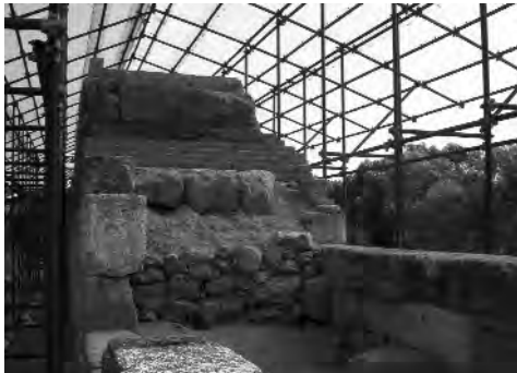
Fig. 2 - Gela: muro ad emplecton ..
