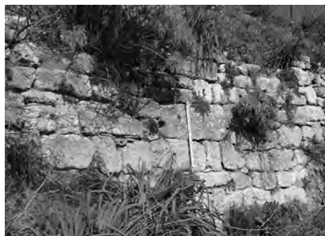
Fig. 128 - Morgantina: tratto delle fortificazioni Sud.
