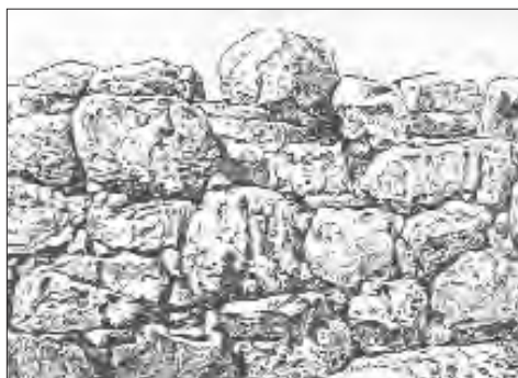
Fig. 5 - Atene: muro miceneo in opera ciclopica (A. Orlandos, 1966).
