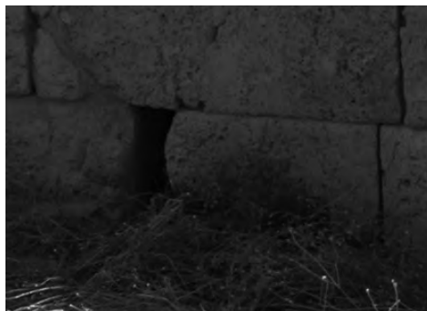
Fig. 69 - Selinunte. Sistema di deflusso delle acque.
