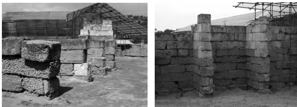
Figg. 107, 108 - Gela: il muro a contrafforti della fortificazione.
