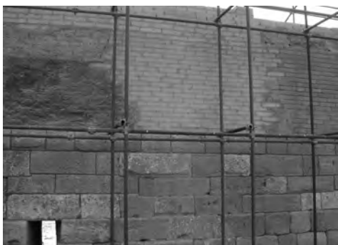
Fig. 105 - Gela: tratto di muro della fortificazione in pietra e mattoni crudi con la canaletta di scolo.
