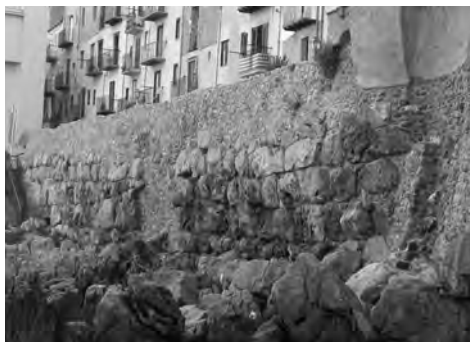
Fig. 91 - Il tratto della fortificazione ad Est della postierla.
