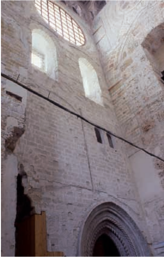
Fig. 16 - Diaconicon , parete meridionale dopo il restauro.
