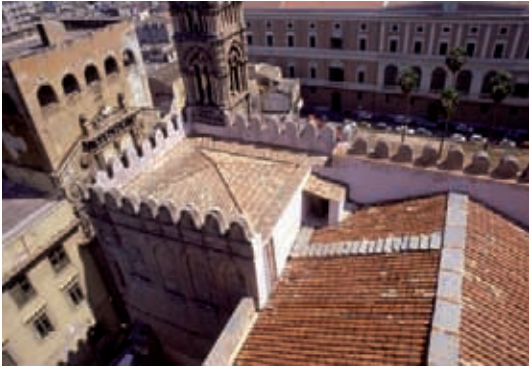
Fig. 3 - Copertura della Prothesis , il tetto a padiglione dopo i restauri.
