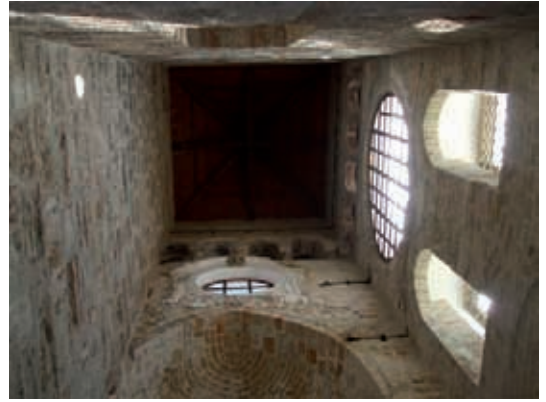
Fig. 5 - Diaconicon , dopo i lavori di restauro.
