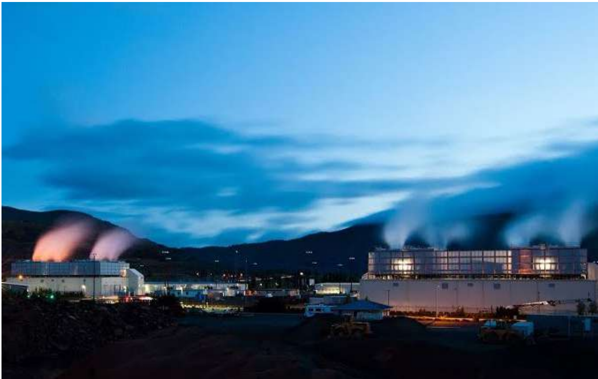
Fig. 4. Il data center di The Dalles in Oregon (Google).
