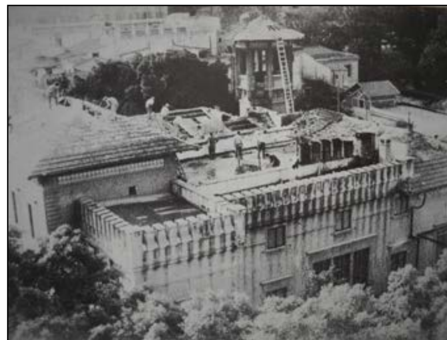
Fig. 3 Demolizione di Villa Deliella.
