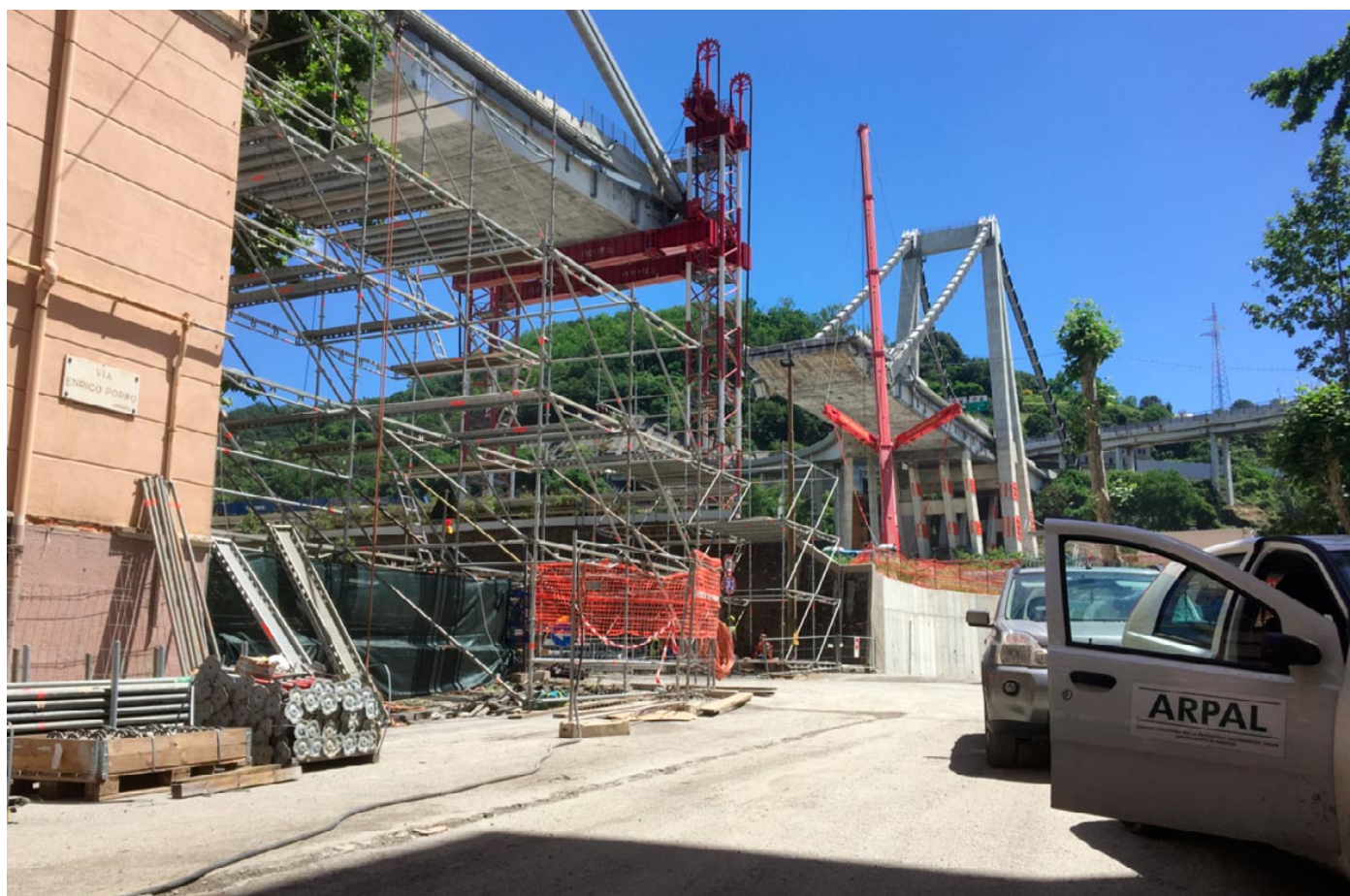
Figura 1: Sopraluogo ARPAL presso il cantiere della demolizione
