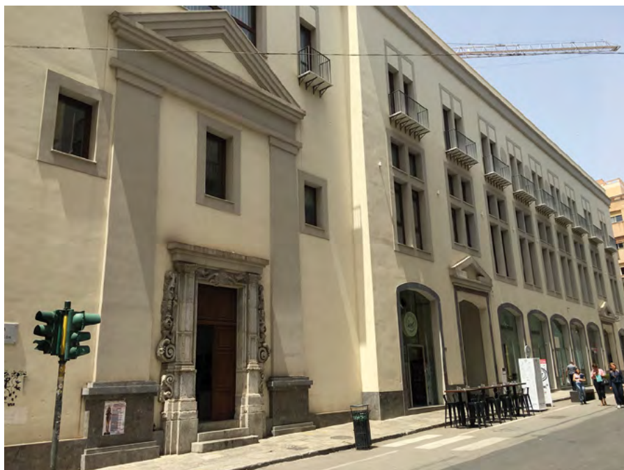
Fig. 4 – L'Area Quaroni, recentemente costruita e nuovo polo residenziale e commerciale di via Maqueda
