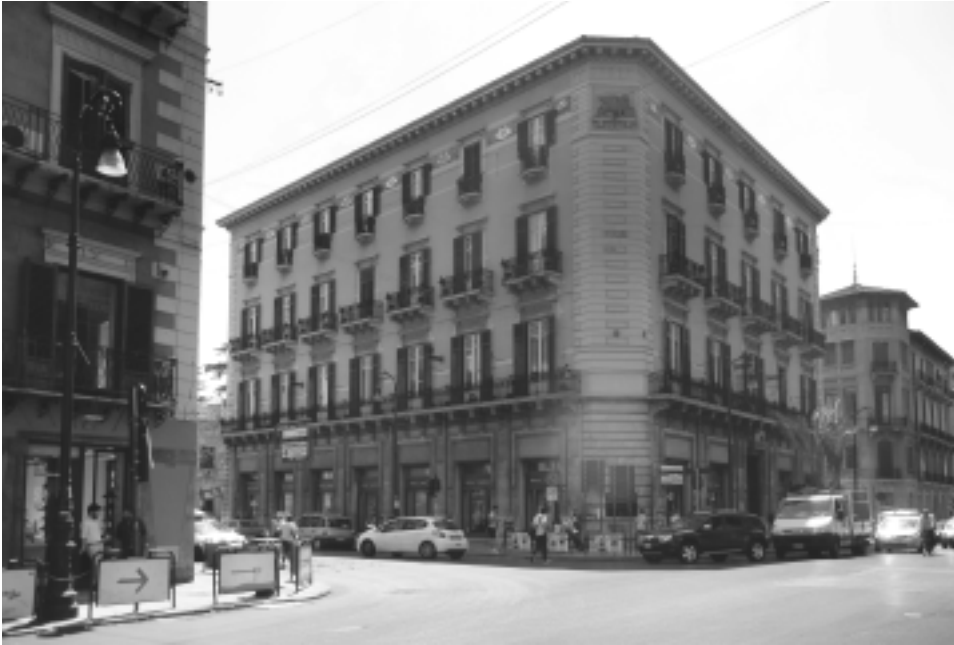
Fig. 3. Palazzo delle Assicurazioni Generali di Venezia in via Roma a Palermo: Ernesto Basile, 1912-1913; veduta d'insieme dei fronti su via Cavour su via Roma con sullo sfondo palazzo Ammirata (fotografia E. Mauro, 2016).
