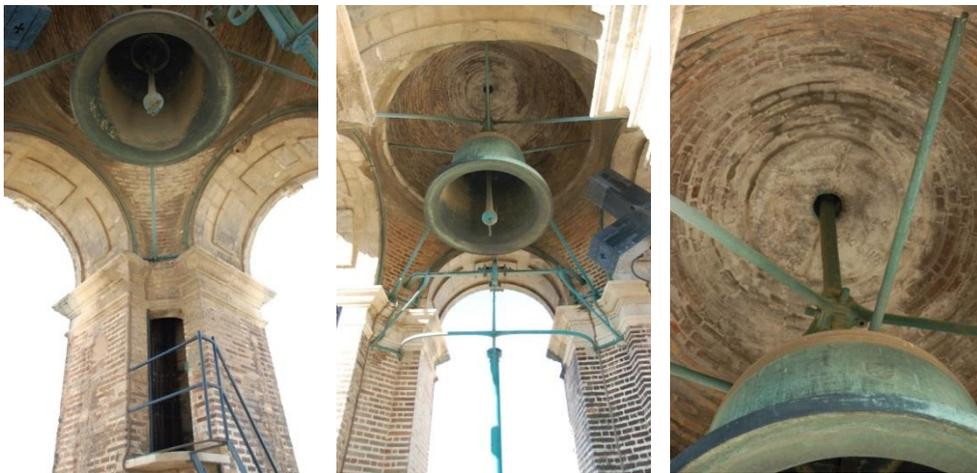
Figg.31-32-33. Sistema di sostegno della campana e collegamento con la statua del *giraldillo*
