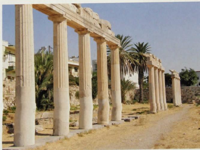
Fig. 2 Kos, ginnasio occidentale, veduta di uno dei portici restaurati della palestra.
