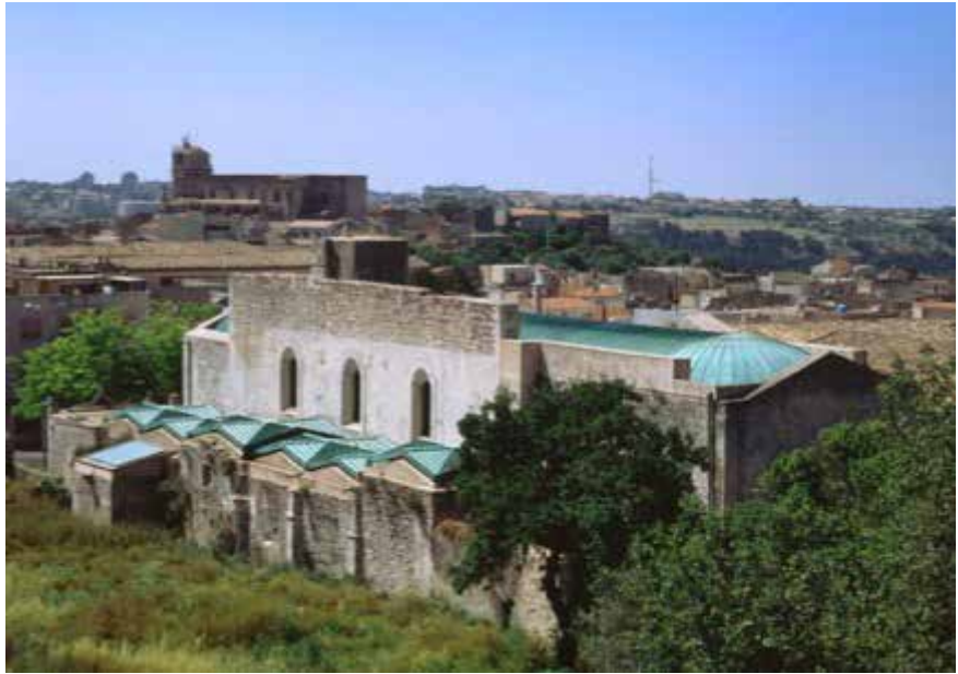
1. - 2. Chiesa di S. Maria del Gesù a Modica. (Restauro di E. Fidone, B. Messina 1992-2005).
