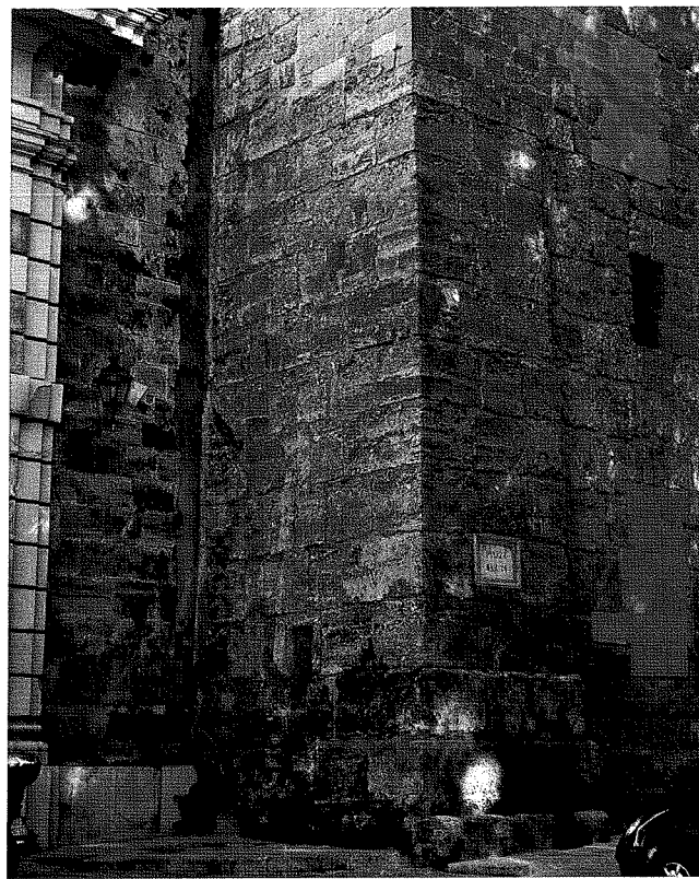
Fig. 4. Risvolto del cantonale e attacco con il corpo di collegamento con palazzo Abatellis (P. Di Franco).
