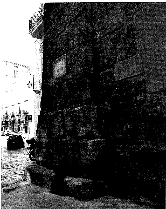
Fig. 3. Dettaglio della 'scarpa' aggiunta da Giacomo Amato con conci dell'Aspra (P. Di Franco).
