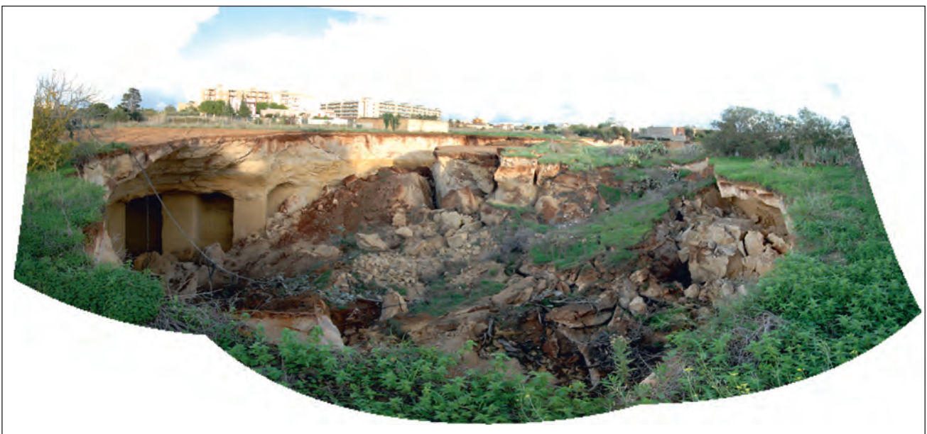
Fig. 2 - Panoramica dell'area interessata dallo sprofondamento ripresa da Nord-Ovest. Sulla sinistra sono ben visibili le camere ed i pilastri della cava sotterranea. - View of the Contrada Amabilina sinkhole, from the North-West. On the left, pillars and chambers of the underground quarry are visible.
