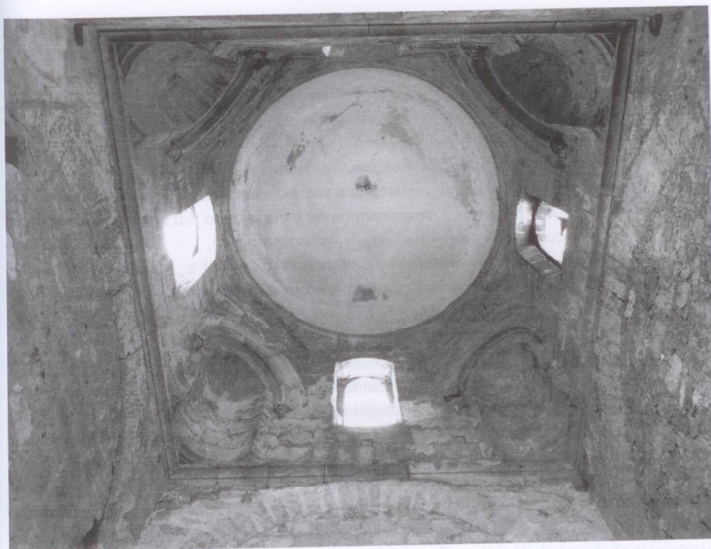
Illustración n° 6. Cappella Basilicò nella chiesa di Santa Maria dello Spasimo a Palermo, intradosso della cupola su nicchie angolari.
