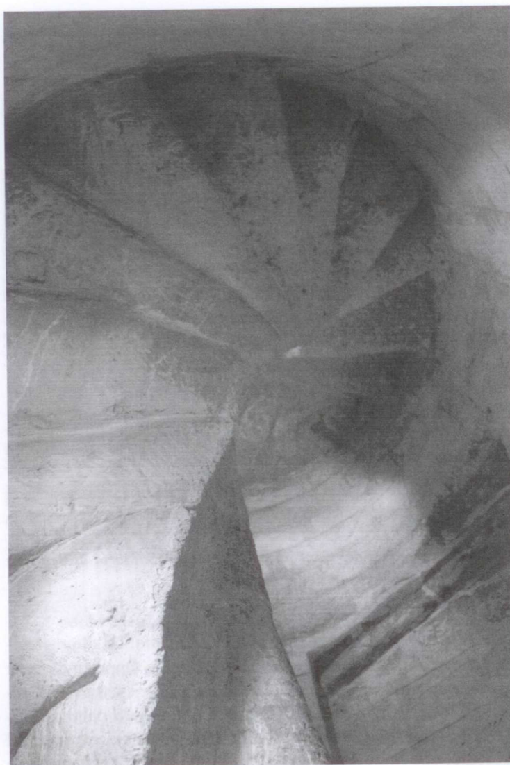
Ilustración n° 5. Scala a chiocciola del tipo caracol de Mallorca nella torre campanaria della Cattedrale di Sassari, intradosso.
