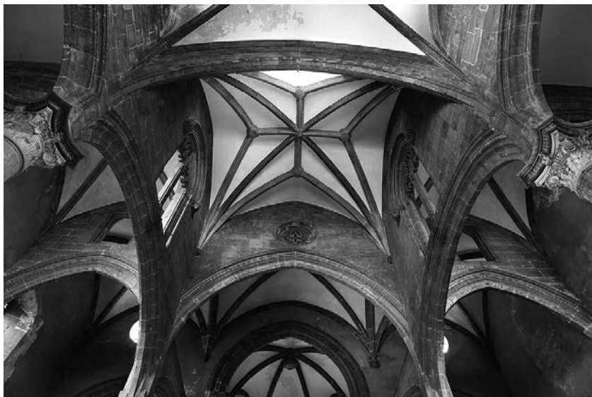
4. Palermo. Chiesa di Santa Maria della Catena, volta a cinque chiavi sulla crociera.
