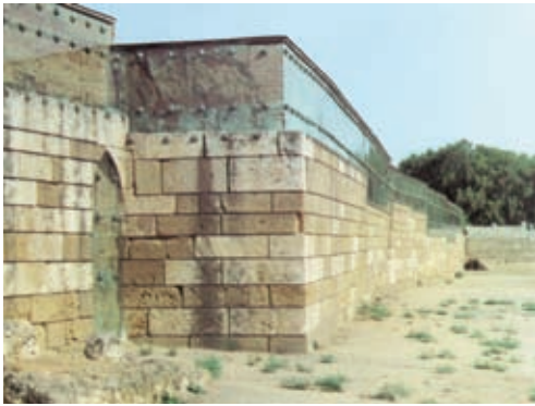
Figg. 3, 4 - Gela, le Mura di Capo Soprano con sopralzo in mattoni di terra cruda nell'intervento di Franco Minissi; dopo la rimozione delle lastre di policarbonato è stata costruita una copertura di protezione.
