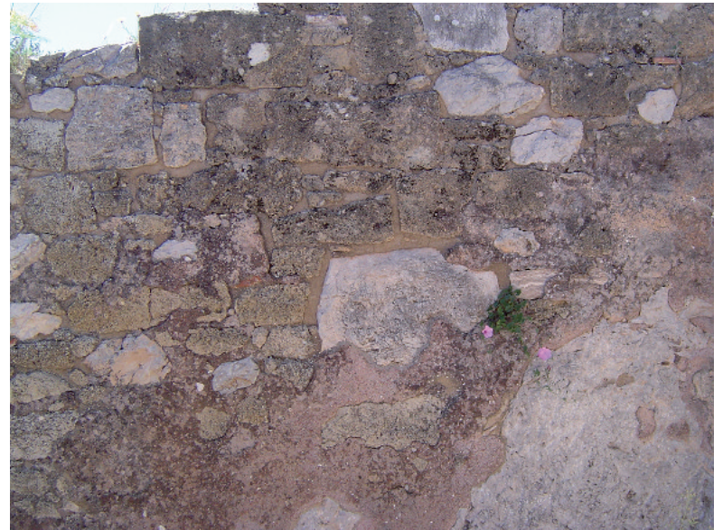
Figg. 11, 12 - A sinistra, strada di accesso all'area dell'Agorà; si notano le corrette integrazioni delle mancanze delle basole con malta cementizia mista a ciottoli e pietre di piccole dimensioni di calcare locale. A destra, esempio di corretto intervento di reintegrazione delle listature mancanti, con materiali tradizionali, applicati con la tecnica del sottosquadro.
