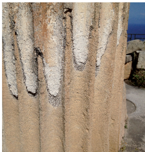
Fig. 8 - Solunto, cosiddetto Ginnasio, lato ovest di una delle colonne del peristilio: si nota il degrado dello stucco a causa della mancanza di consolidamento e il restauro.
