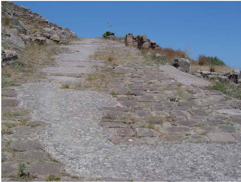
Figg. 11, 12 - A sinistra, strada di accesso all'area dell'Agorà; si notano le corrette integrazioni delle mancanze delle basole con malta cementizia mista a ciottoli e pietre di piccole dimensioni di calcare locale. A destra, esempio di corretto intervento di reintegrazione delle listature mancanti, con materiali tradizionali, applicati con la tecnica del sottosquadro.
