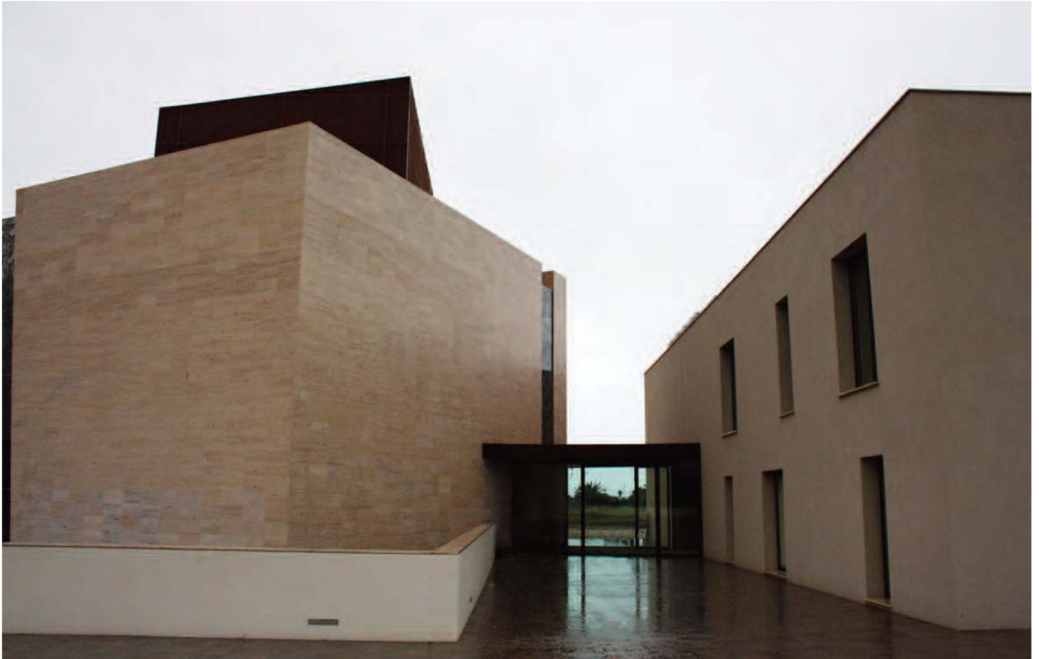
4. Vista da nord. Il corpo dell'aula liturgica e la casa canonica.
