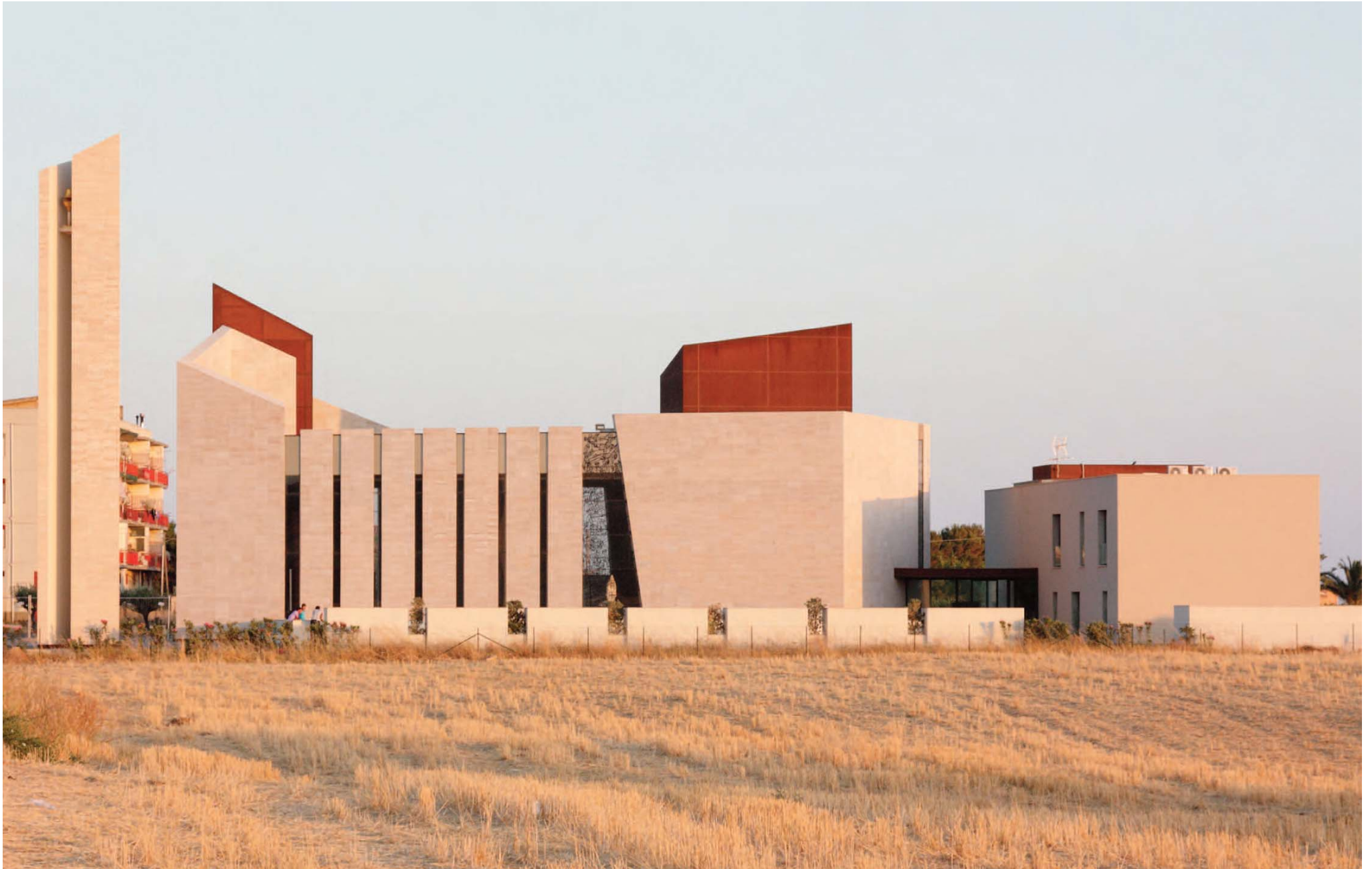
2. Vista da nord
